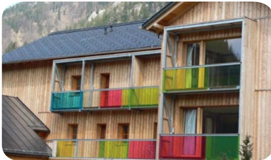
Neben den bekannten Vorteilen von Pilkington **Optilam**<sup>TM</sup> aus Floatglas im Bereich der Splitterbindung, bietet Pilkington **Optilam**<sup>TM</sup> aus Einscheibensicherheitsglas eine hohe thermische und mechanische Belastbarkeit.
