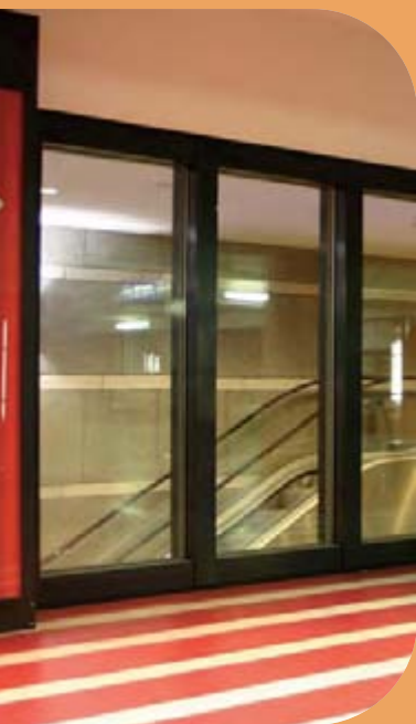
Parking Centre Commercial Les Passages, Boulogne (F) : Cloison acier EI (coupe-feu) 180 minutes réalisée avec Pilkington Pyrostop® .
