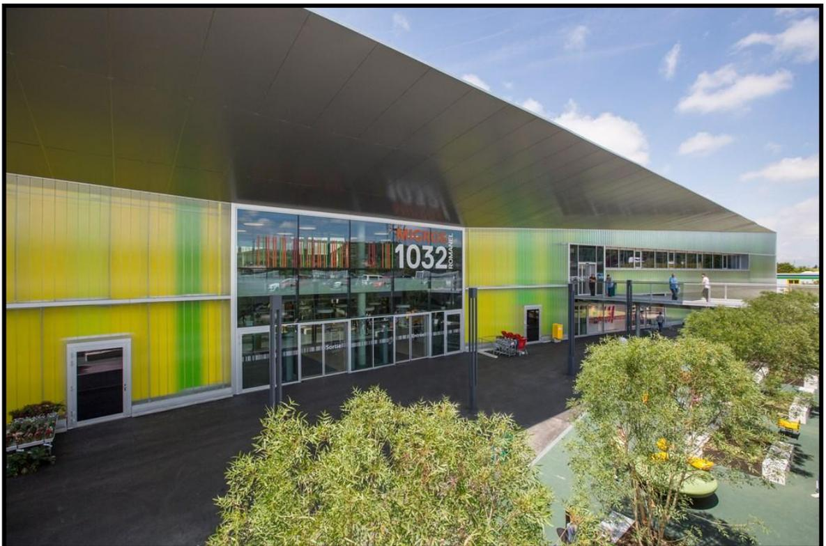
Aus sicherheitsgründen wurden Teile der Verglasungen als thermisch vorgespanntes und heißgelagertes Pilkington **Profilit™** T-H ausgeführt.
