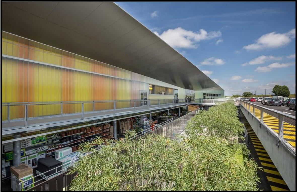
Zwischen Wand und Verglasung befinden sich Beleuchtungselemente, die die Fassade am Abend in einem freundlichen und attraktiven Licht erstrahlen lassen.
