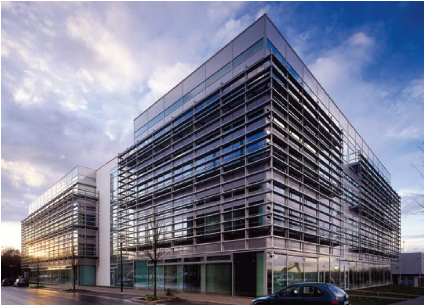
Große Glasflächen und die vorgesetzten Sonnenschutz-Elemente prägen das Fassadenbild.
