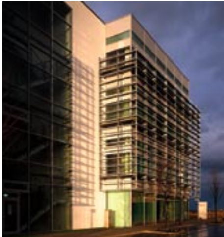
Einer der drei verglasten Treppenträume, die sich an den Außenseiten des Gebäudes befinden.
