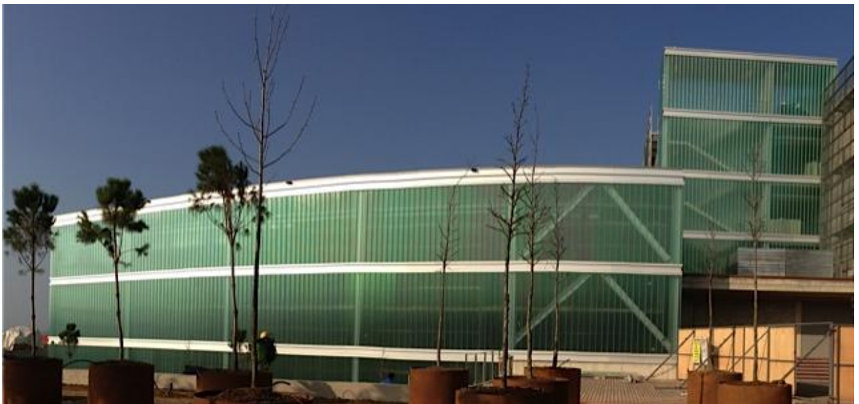
Bild 1: Halle mit nautischem Simulationsbecken sowie Treppenhausverglasungen
