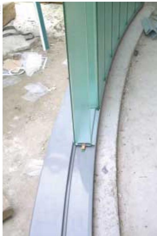
Pilkington Profilit TM Die Verarbeitung der gewölbten Fassade im Detail
