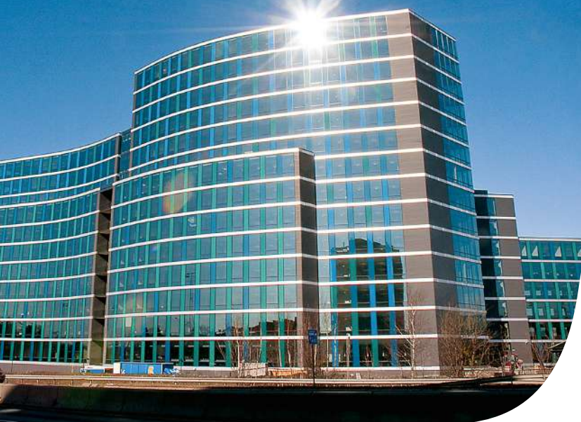
Foto: Trond Løvelsen / Byggeindustrien
