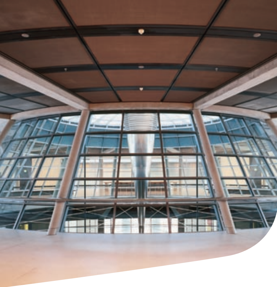
Рейхстаг, Берлин: EW 30-Зенитный фонарь- наклонное остекление Пресслоби над пленарным залом.
