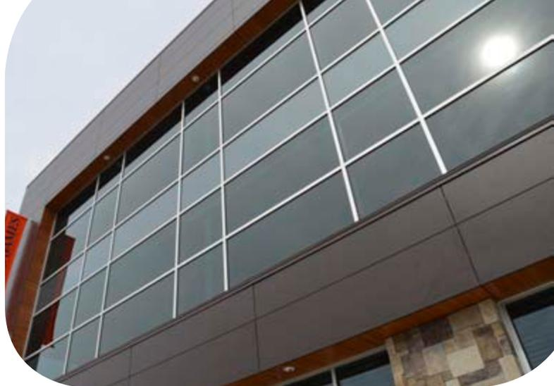
Die Außenscheibe von Pilkington **Suncool™** Dynamic kann aufgrund der hohen Absorption Temperaturen von mehr als 65° C erreichen. Dies kann bei direkter Berührung mit der Haut schmerzhaft sein. Daher sollte die konkrete Einbausituation vorher abgeklärt werden.
