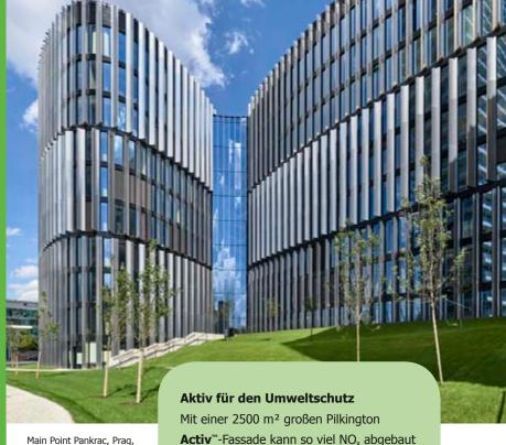
Main Point Pankrac, Pra Tschechien. Activ<sup>™</sup>-Fassade kann so viel NO<sub>x</sub> abgebaut werden, wie zwei bis 20 Autos, abhängig von der Art des Motors, mit einer Jahresfahrleistung von 14000 km ausstoßen. Für den Privathaushalt bedeutet das: Eine 35 m² große, mit Pilkington Activ<sup>™</sup> verglaste Fläche im Haus kann bis zu 10% der ausgestoßenen Stickoxide einer Ölhei-
