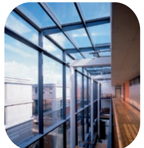
Glasfassade an der Schnittstelle zwischen den Objektbereichen ComIn genius und ComIn start.
