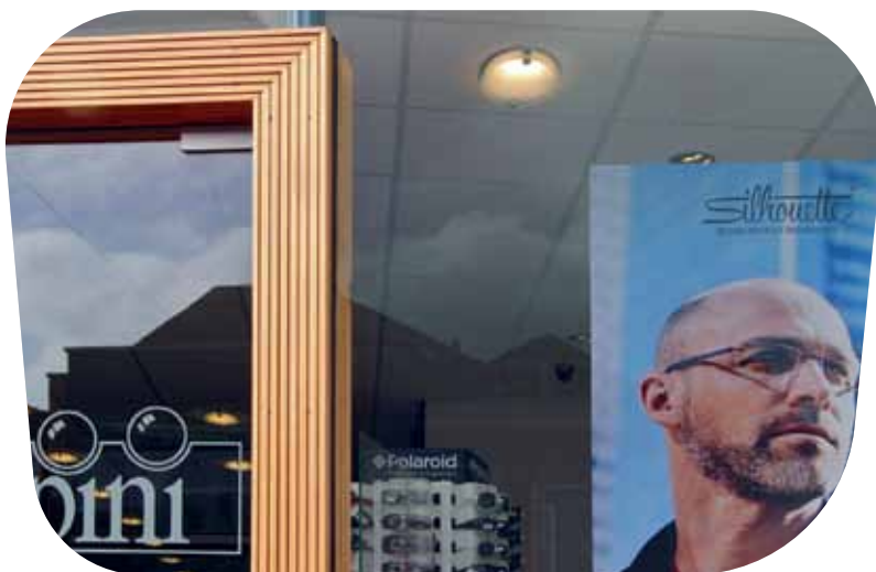
Die großen Panoramasscheiben wurden mit Pilkington OptiView™ Protect verglast, im Unterschied zu den Türen.
