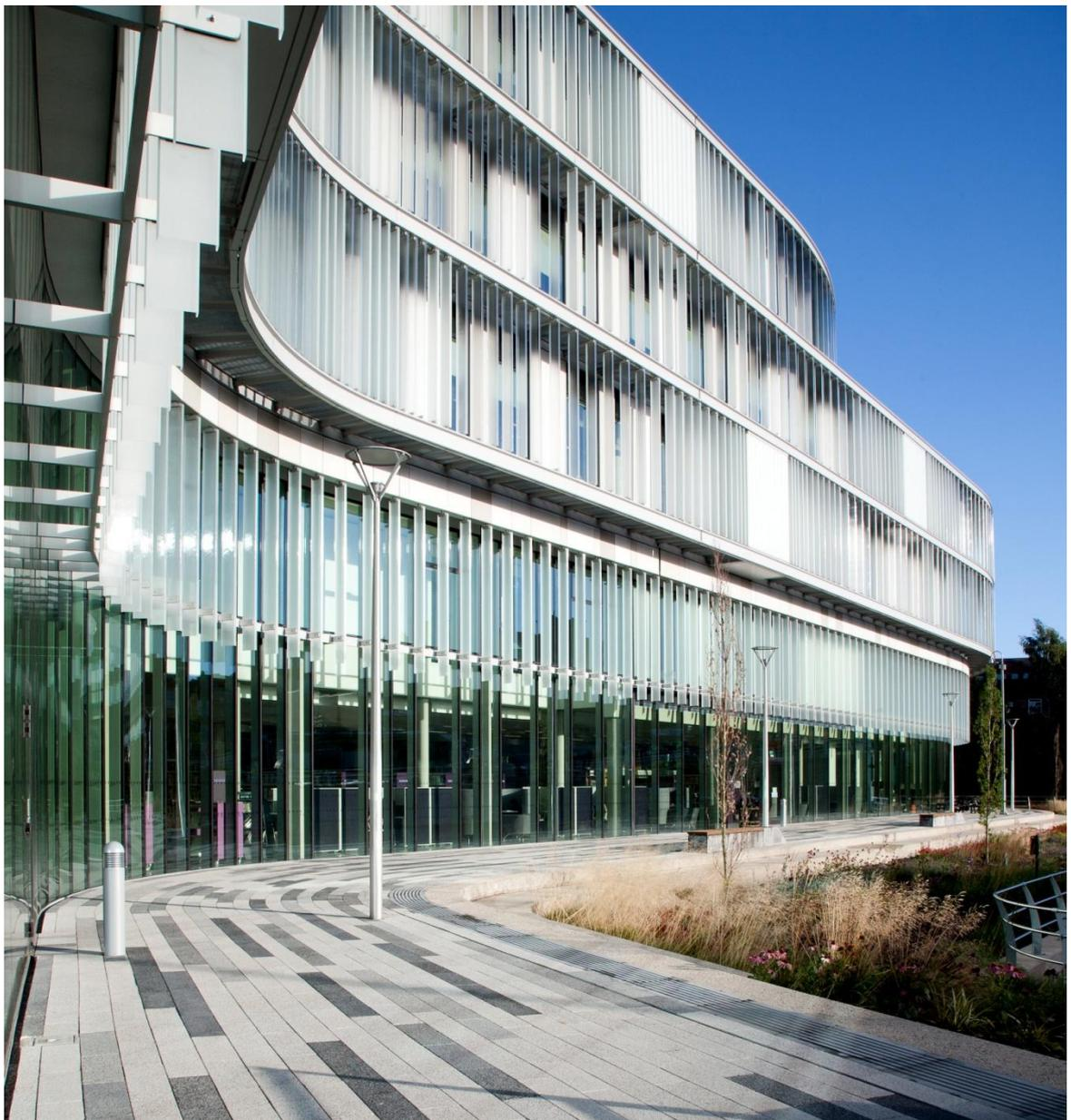
In weiteren Fassadenbereichen wurden die Produkte als Warmfassade in Kombination mit sandgestrahltem Pilkington **Profilit™** Opal und transluzenter Wärmedämmung eingesetzt:
