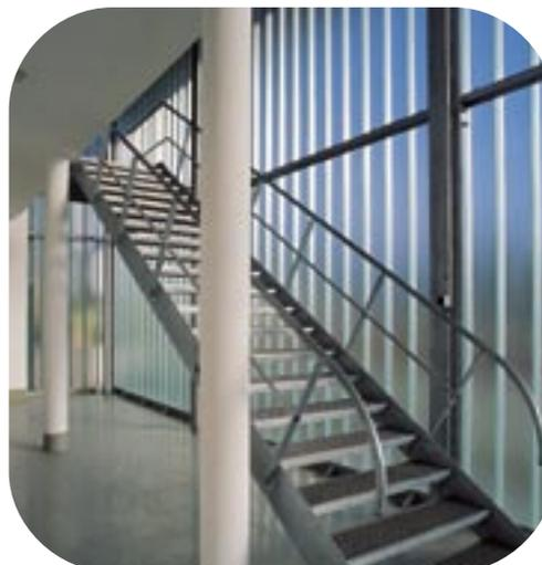
Der hohe Tageslichteinfall bei eingeschränkter Durchsicht sowie die funktional-industrielle Ästhetik waren entscheidende Faktoren bei der Fassadengestaltung mit Pilkington **Profilit™**.
