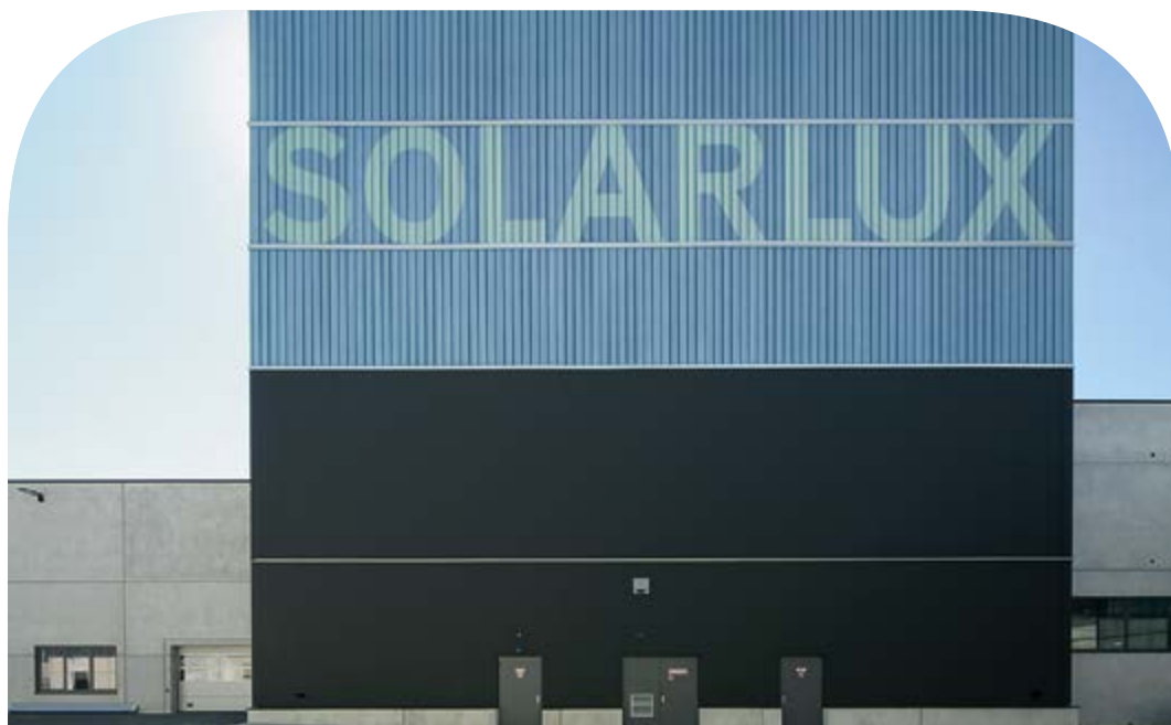
SOLARLUX Campus, Melle, Deutschland
