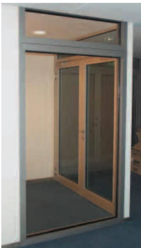
BBE F 90-Verglasung mit Pilkington Pyrostop zur Absicherung eines Fluchttreppenhauses im Business Tower der Nürnberger Versicherung (Systemabmessungen 1.370 mm x 2.148 mm; 1.370 mm x 422 mm Oberlicht).
