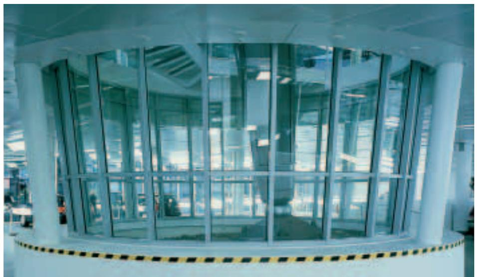
Hohe Brandlasten durch Fahrzeuge: Die F 90-Festverglasung im Erdgeschoss des Pylonenauges.
