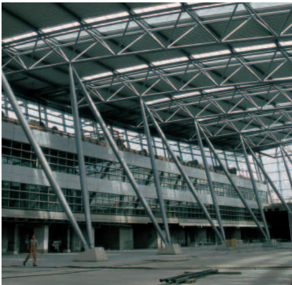
Die an beiden Enden konisch auslaufenden Stützen für die Dachkonstruktion sind mit einem speziellen Brandschutzanstrich versehen, um die Standzeit im Brandfall zu erhöhen.
