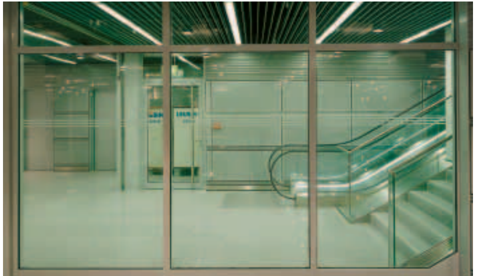
Helle, übersichtliche und gut gekennzeichnete Fluchtwege: Brandschutzgläser wurden gezielt eingesetzt, um Flüchtenden im Brandfall die „Angst vor dem Unbekannten“ zu nehmen.
