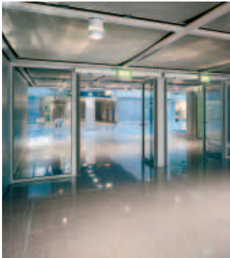
Brandschutz-Türanlage am Durchgang zwischen der Haupthalle und den Arkaden mit Geschäften; Sichtbar hier auch die „offene“ Deckengestaltung mit Blick auf die Haustechnik.
