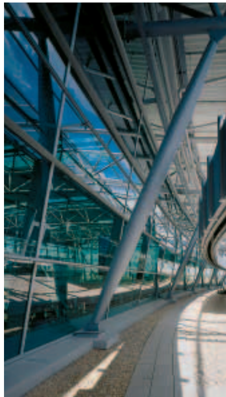
Haltestelle der Kabinenbahn oberhalb der Vorfahrt.
