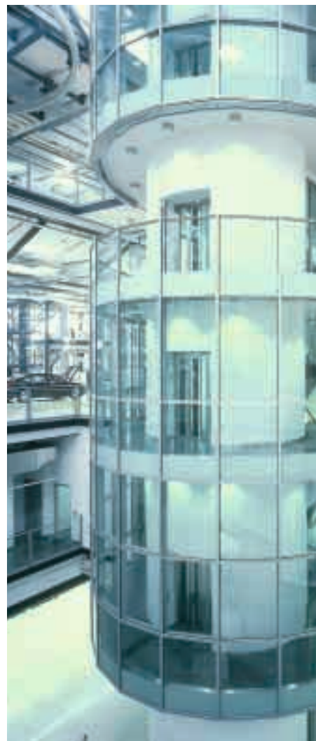
Zwei „Nockentower“ bilden den beidseitigen Abschluss eines Bürotraktes innerhalb der Montage. Ebenso wie die innenliegende Fassade erhielten sie eine Brandschutzverglasung mit Pilkington Pyrostop in der Feuerwiderstandsklasse F 30.
