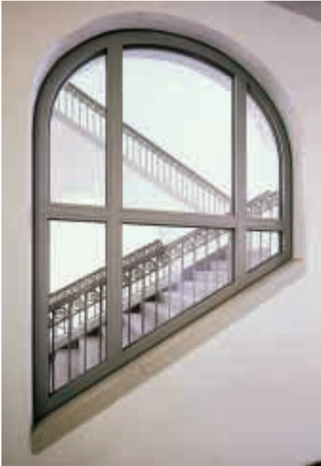
F 90-Festverglasung mit Pilkington Pyrostop -Modellscheiben zu einem der Treppenträume.
