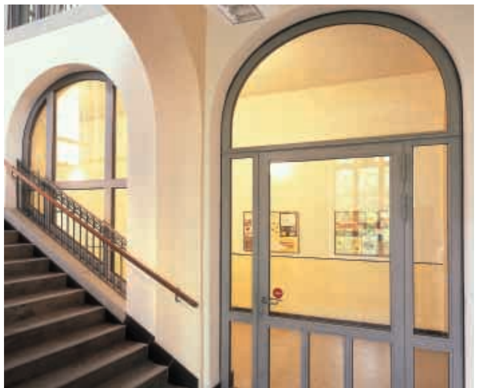
F 30/T 30/RS-Türsysteme mit F 30-Anschlussbauteilen sichern auf allen vier Gebäudeebenen die Fluchttreppenträume.
