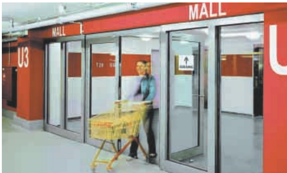
Eine bequeme Passage mit großzügigem Überblick bietet diese insgesamt 6,25 Meter breite F 90/T 90-Türanlage in der Tiefgarage des DuMont Careés in Köln.
