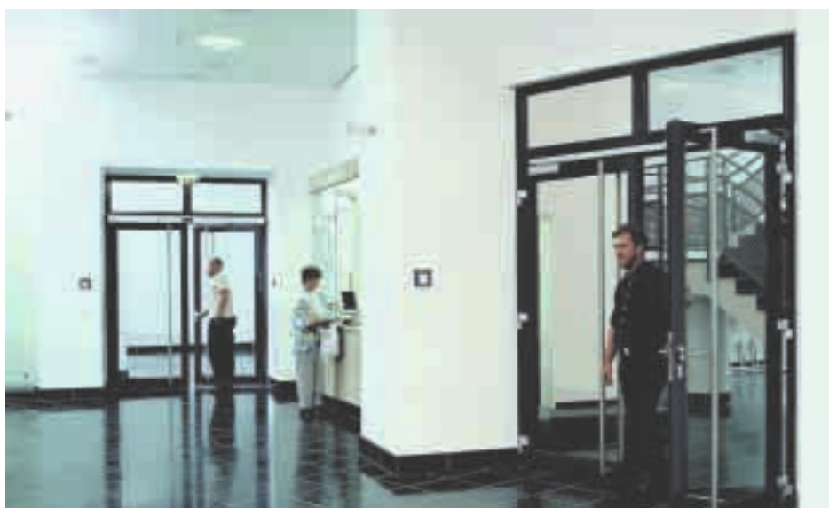
Für Transparenz und ungehinderte Passage sorgen diese großflächig verglasten F 30/T 30-Feuerschutzabschlüsse im sanierten City-Hochhaus am Augustusplatz in Leipzig.
