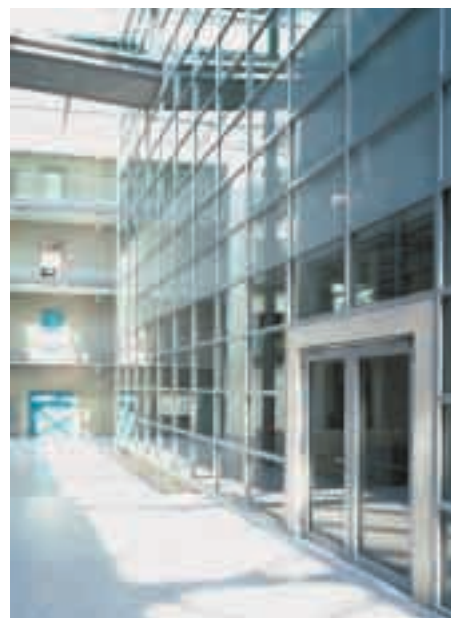
F 90/T 90-2-Türsysteme in der F 90-Trennwand: Der Bauteilanschluss erfolgte über Sichtbetonzargen.
