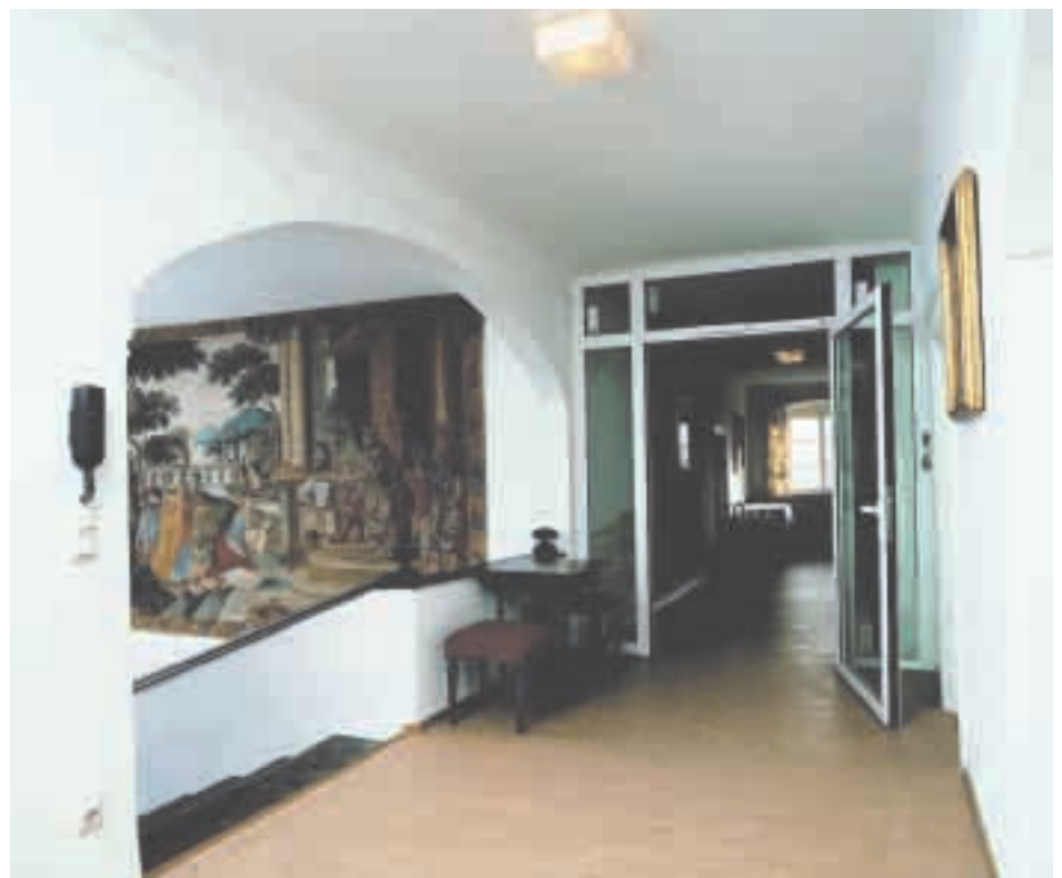
Schlankes Stahlprofil – große Durchgangsweite: F 30/T 30-Elemente im sanierten Kloster Reutberg bei Bad Tölz.
