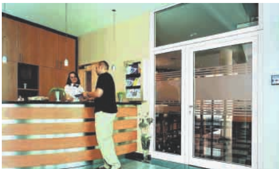
Eine F 30/T 30-Feuerschutztür sorgt für großzügige Optik im ART-Hotel in Ahlen. Die Glasätzung dient als Auflaufschutz.
