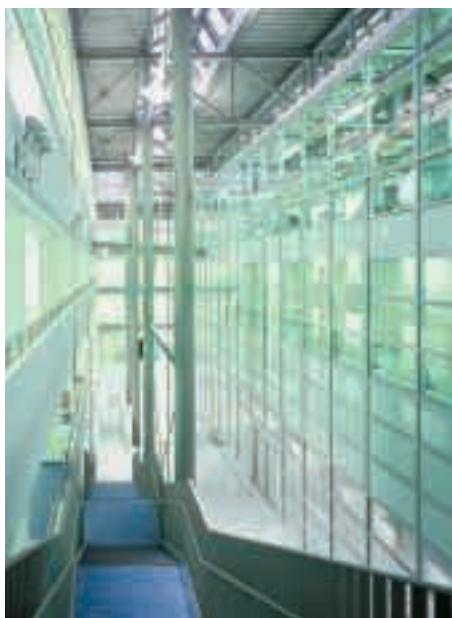
Die Schnittstelle zwischen Sportbereich und Klassenräumen bildet eine Brandschutz-Trennwand, die im unteren Bereich in F 90, im oberen Bereich in G 30 ausgeführt ist.
