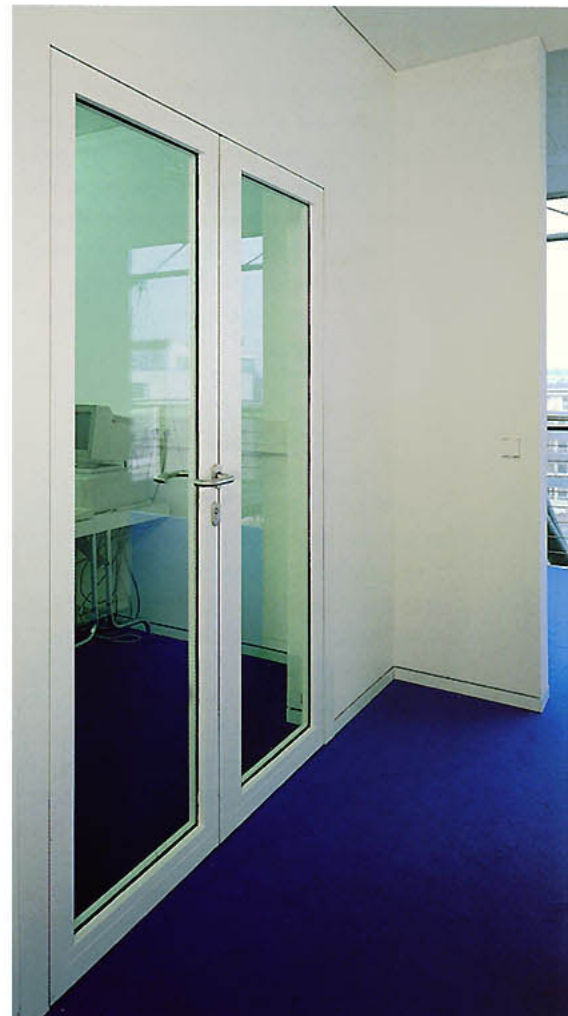
Die an den Fluchtweg grenzenden Büro- und Aufenthaltsräume wurden ebenfalls mit T 30-Türen ausgestattet (System: Forster).
