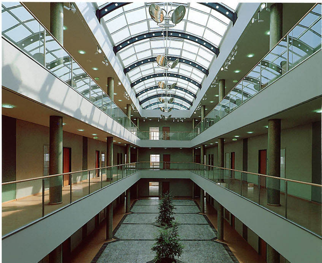
Die große „Wandelhalle“ des LOCC Leipzig: Ein Glasdach bringt über die Wandöffnungen Licht in die Büroräume.
