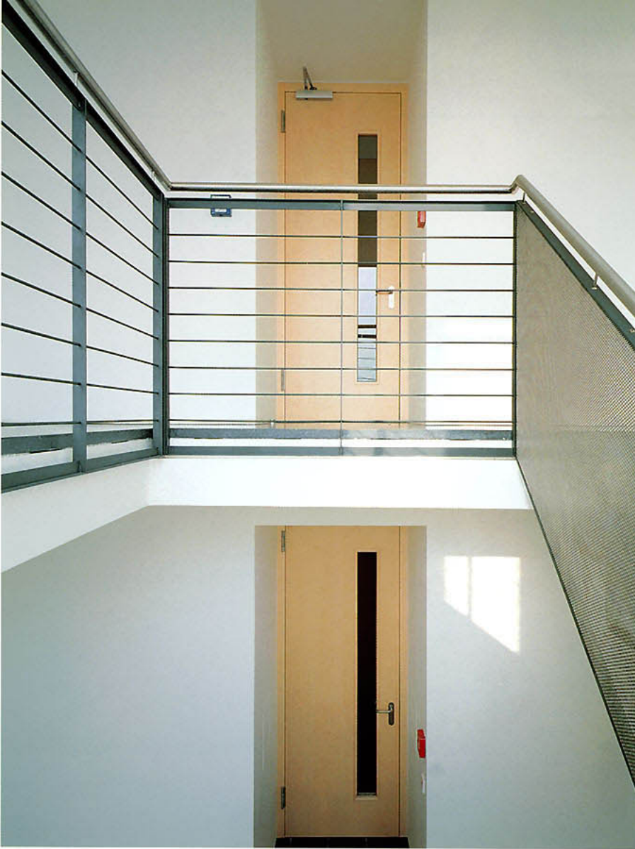
T 30-Türen mit PYROSTOP sichern die Zugänge zu den notwendigen Treppenhäusern. System: Schörghuber
