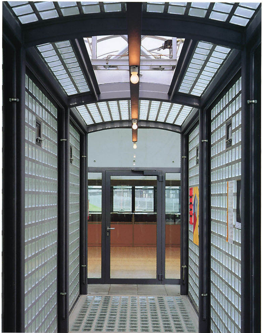
Ästhetik in Glas, Stahl und Beton: Die „gläserne Schleuse“ zwischen Neubau und Maschinenhalle durchquert einen Brandabschnitt und ist beidseitig mit T 30 Türanlagen abgesichert (System Jansen AG / PYROSTOP).
