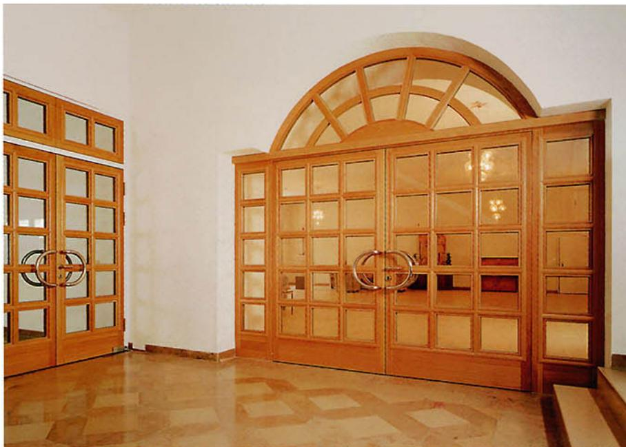
◀ Nach Architektenentwurf gebaut: Die T 30-2 Bogentür von der Mantelhalle zu den Trepperräumen.
