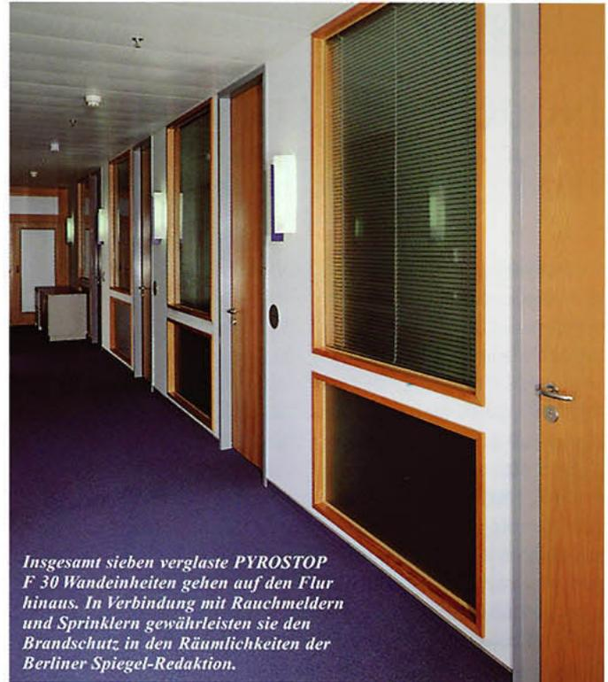
*Insgesamt sieben verglaste PYROSTOP F 30 Wandeinheiten gehen auf den Flur hinaus. In Verbindung mit Rauchmeldern und Sprinklern gewährleisteten sie den Brandschutz in den Räumlichkeiten der Berliner Spiegel-Redaktion.*
