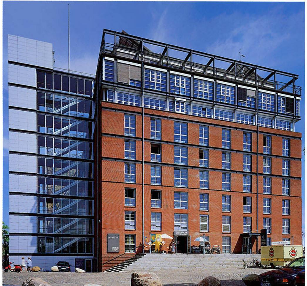
Der denkmalgeschützte Hamburger Elbspeicher - eine um 1890 errichtete Konstruktion aus Ziegeln und vorgefertigten gußeisernen Stützen und Trägern.
