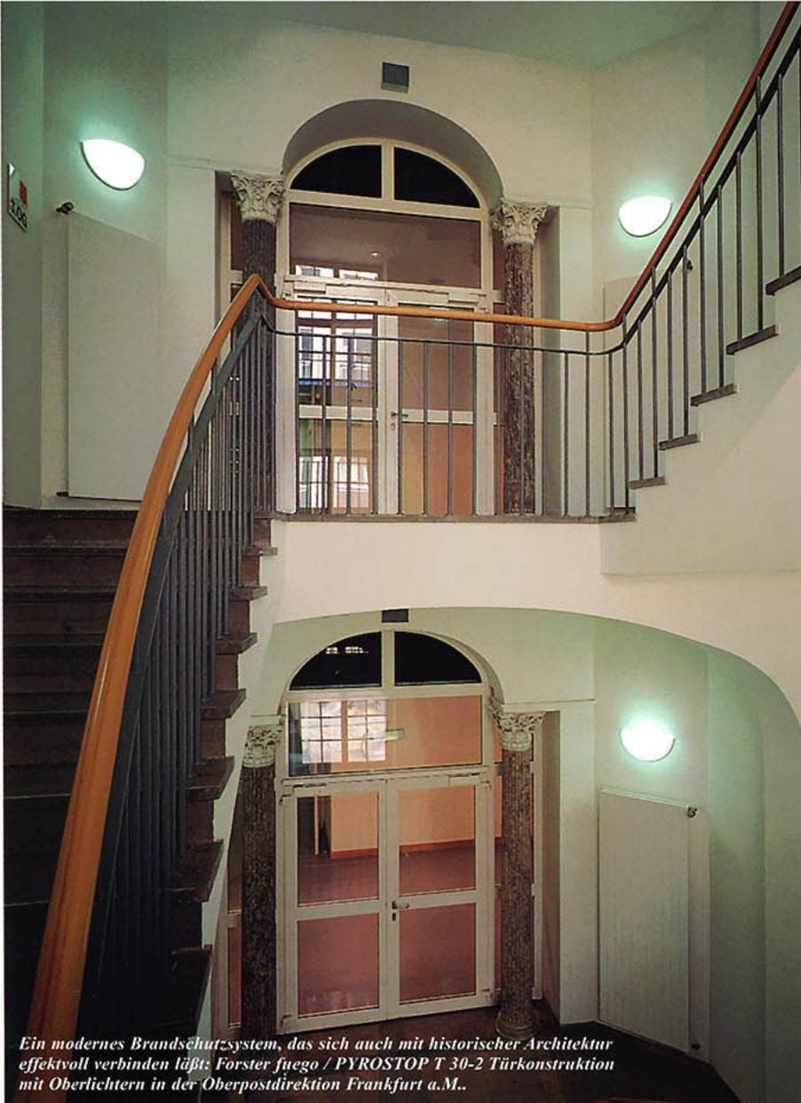
Ein modernes Brandschutzsystem, das sich auch mit historischer Architektur effektiv verbinden lässt: Forster fuego / PYROSTOP T 30-2 Türkonstruktion mit Oberlichtern in der Oberpostdirektion Frankfurt a.M..
