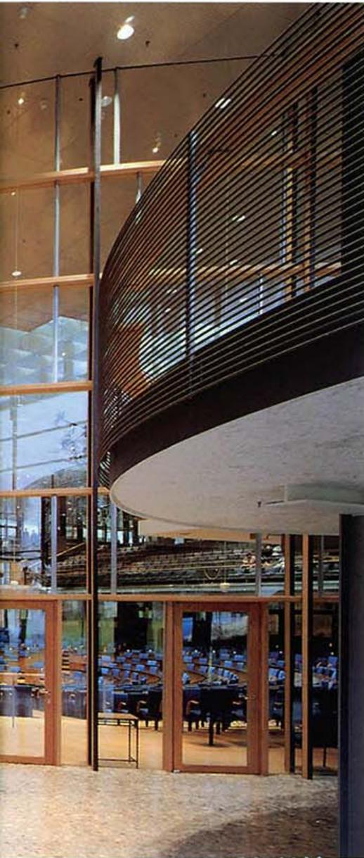
◀ **Sonderlösung Plenarsaal, Bonn:** Die polygonale G 30-Brandschutztrennwand zum Plenarsaal erfüllt zugleich hohe Schallschutz- und Sicherheitsanforderungen (PYRODUR / Eich Wandsystem).
