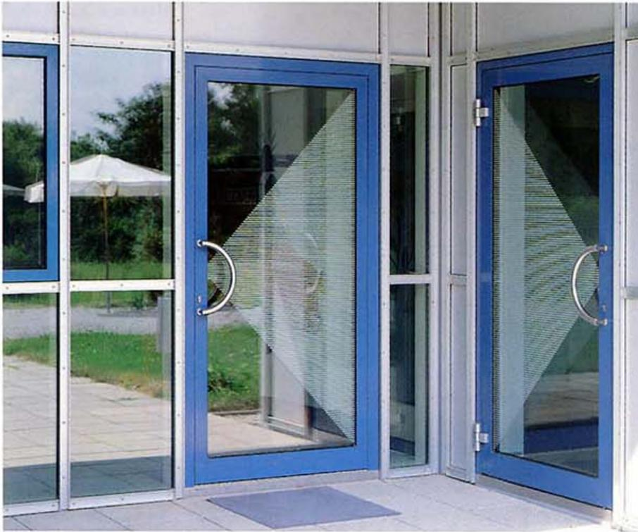
*Kreiskrankenhaus Starnberg: Die siebbedruckten T 30-Türen (PYROSTOP / System Forster) fallen in einen Inneneckbereich der Fassade, der vor möglichem Feuerüberschlag zu schützen ist.*
