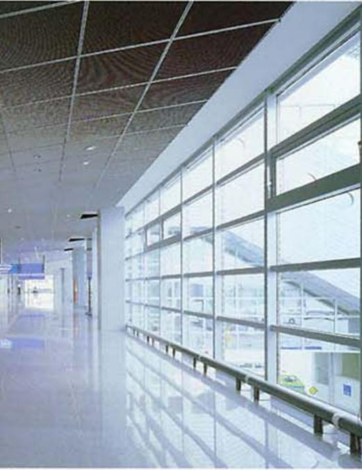
◀ Flughafen Frankfurt, Terminal 2: Die Abmessungen der F 90-Trennwand zwischen Busgate-Abgängen und Ankunft liegen außerhalb der bauaufsichtlichen Zulassung und waren Gegenstand eines gesonderten Gutachtens (PYROSTOP / MBB Glissa 2000).
