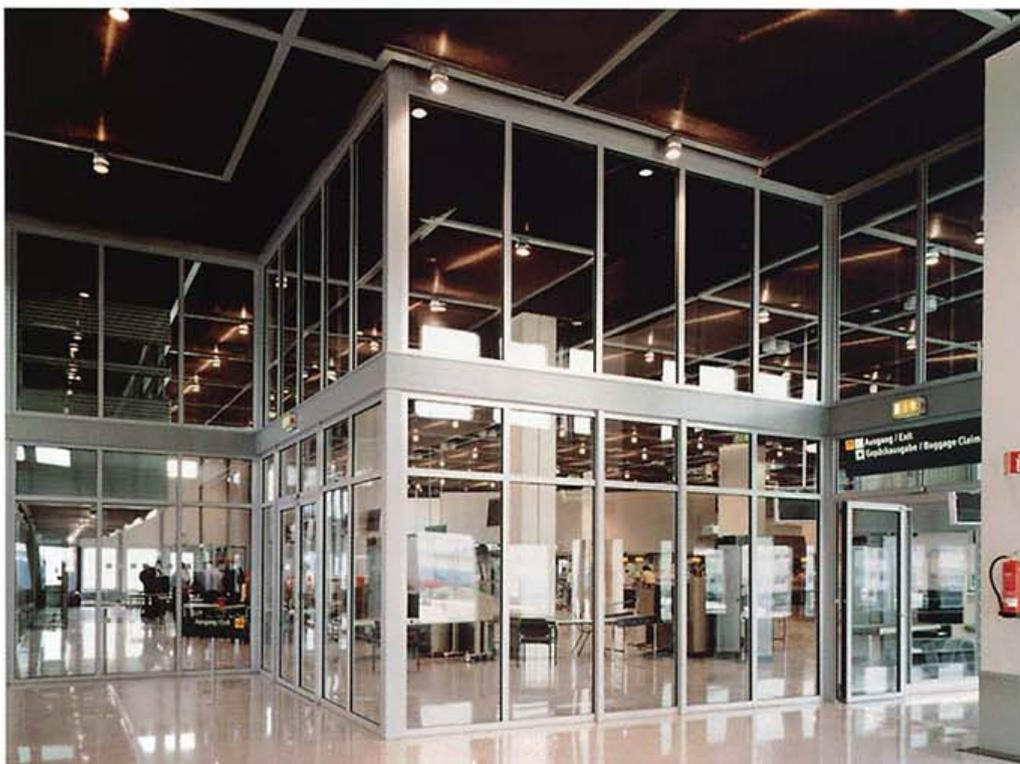
eine gute Grundlage auch für objektbezogene Systemzustimmungen im Einzelfall gegeben wäre. Als drittes nennen die Architekten einen pragmatischen Grund, nämlich den Vorteil nachträglich auswechselbarer Rahmendeckschalen und die Austauschmöglichkeit besonders gefährdeter Türanschlüsse. Gerade im Flughafenbereich mit seinem hohen Aufkommen an Reisenden, Dienstleistern, mobilen Transport- und Reinigungsgeräten etc. sind
