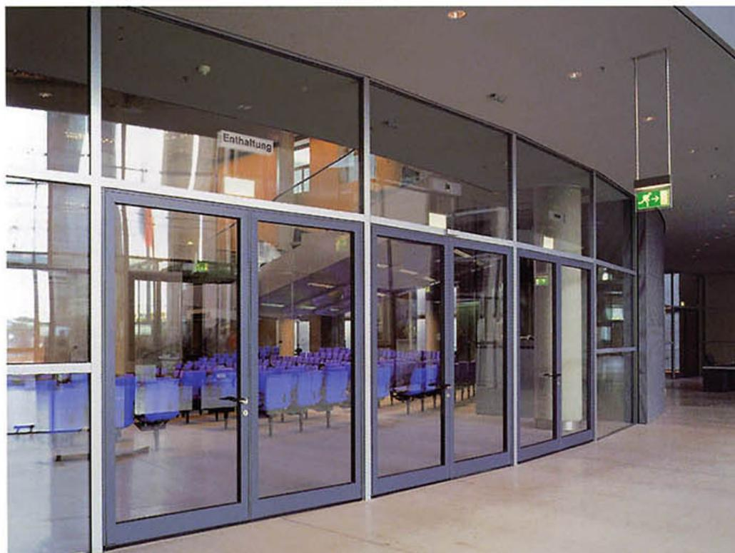
▲ *Ja, Nein, Enthaltung: Von und zur Abstimmung geht es geordnet durch Dreiergruppen von beidseitig beschlaglosen T 30-2-Türsystemen in XXL-Abmessungen (Flügelhöhe 2,70 m).*
