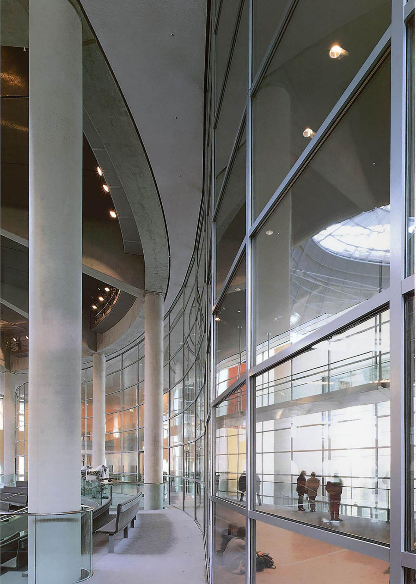
schaligen Glastyp mit optimierter Gasfüllung im Scheibenzwischenraum, bei dem die Brandschutz-Verbundglaspakete beidseitig angeordnet sind. In den Abmessungen der einzelnen Funktionsglas-Segmente ging man an die produktions-technischen Grenzen: bis zu 1,35 m x 2,70 m messen die Scheiben und erreichen damit ein Gewicht von max. 290 kg pro Scheibe.
