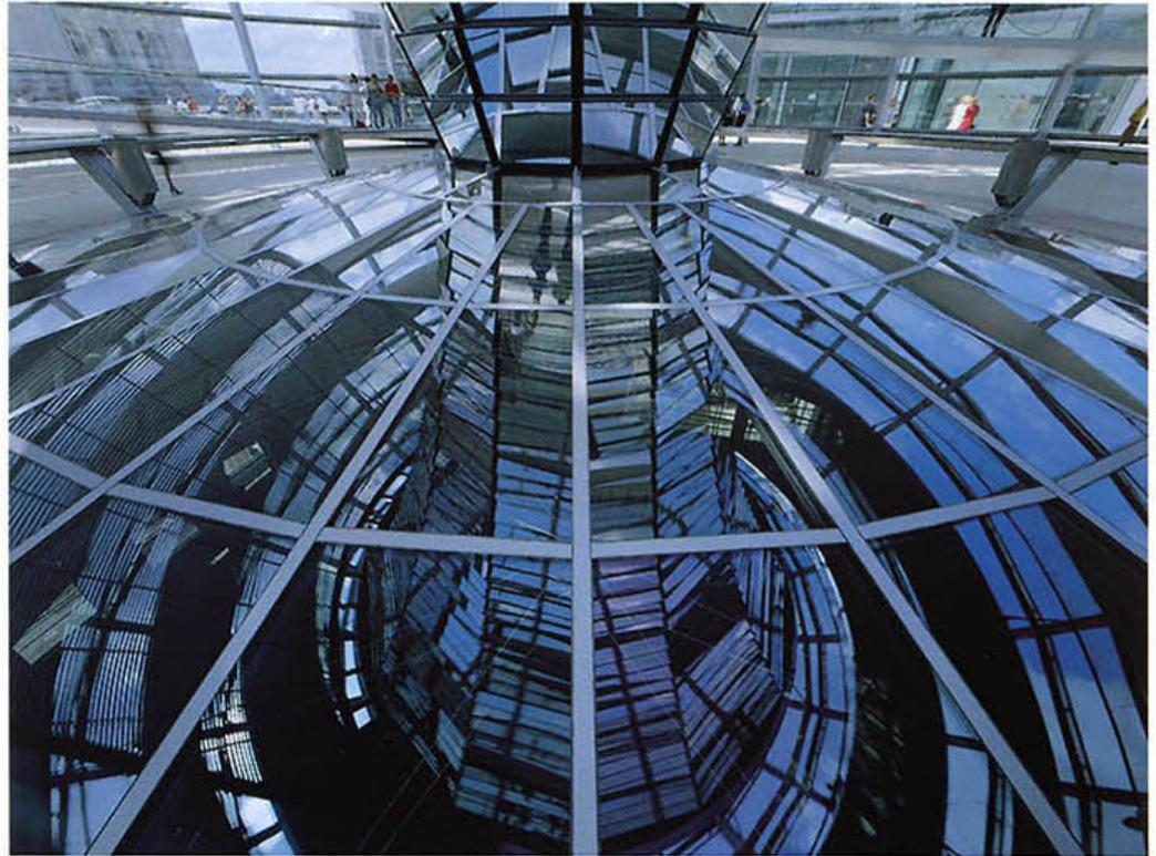
Der obere Teil der Brandschutz-Dachkuppel mündet in die Besucherzone. Er ist als G 30-Verglasung mit Schallschutz-, Wärmeschutz- und Sicherheitsfunktionen ausgeführt und zu Reinigungszwecken begehbar.
