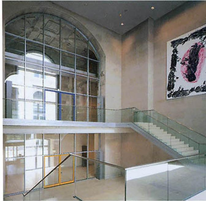
◀ Die schlanken, symmetrischen Rahmenprofile der Brandschutztüren (System MBB Glissa 2000) sind den Funktionsbereichen farblich entsprechend gekennzeichnet.
