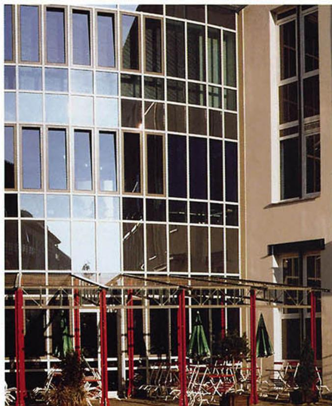
Einheitliche Fassadenoptik durch übergangslose Ausführung von Brandschutz- und „Normalfassade“. Foto: SCHÜCO
