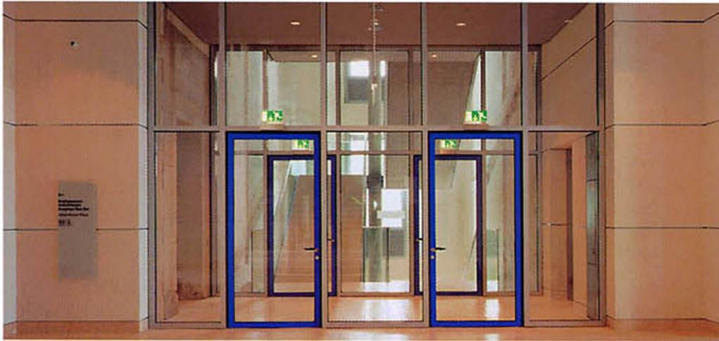
*Transparente T 30-Türsysteme mit F 30-Anschlußbauteilen trennen die einzelnen Funktionsbereiche und sichern Treppenträume, Büros und Sitzungssäle ab. Zudem wird die Tageslichtnutzung optimiert.*
