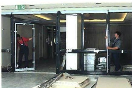
*Großflächig verglaste T 30-Feuerschutzabschlüsse mit F 30-Festverglasungen machen den Eingangsbereich der Veranstaltungshalle zum repräsentativen Foyer. (Hörmann / Pilkington Pyrostop).*
