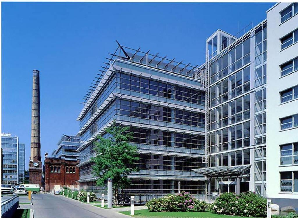
Abb. 5: Durch die Separierung und die geringe Bauhöhe erzielen die transparenten Einzelblöcke ihre Leichtigkeit. Fassadenübergänge von F 90 auf „F 0“ sind weder bei den Profilen noch beim (Brandschutz-)Glas sichtbar.
