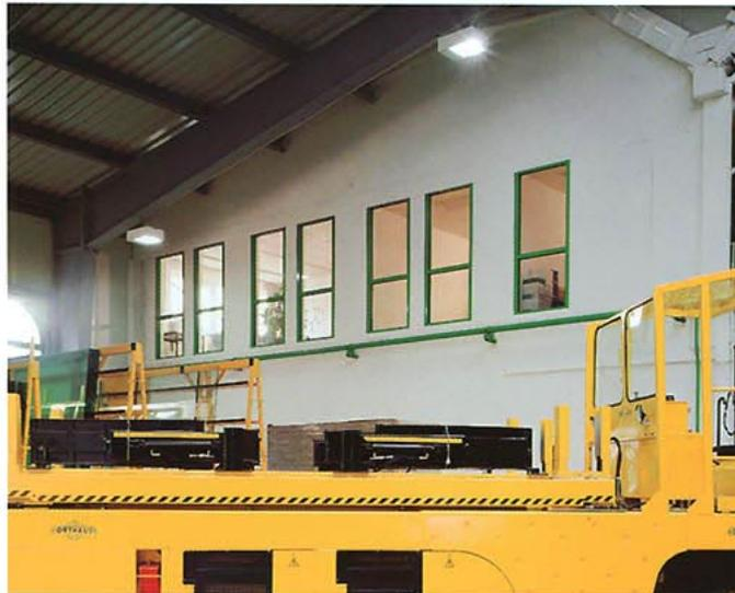
Lichtöffnungen in Brandwänden: Hier kommen ausschließlich bauaufsichtlich zugelassene System der Feuerwiderstandsklasse F 90 / T 90 in Frage.
