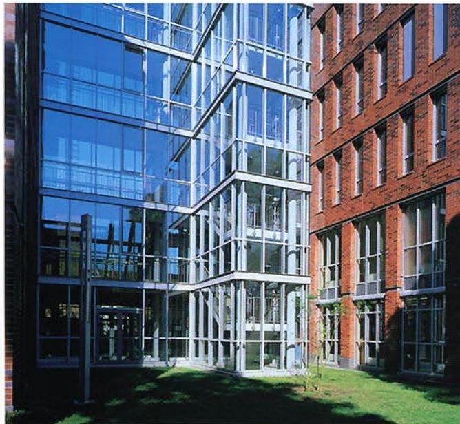
◀ **Abb. 2: Die geschossübergreifenden F 90-Verglasungen EG/1.OG in den Lochfassaden (rechts im Bild) sind in der Pfosten-Riegelkonstruktion Leininger VIII ausgeführt. Bei den Einzelfenstern in den übrigen Geschossen kam das System Leininger IV mit Pilkington Pyrostop zum Einsatz.**
