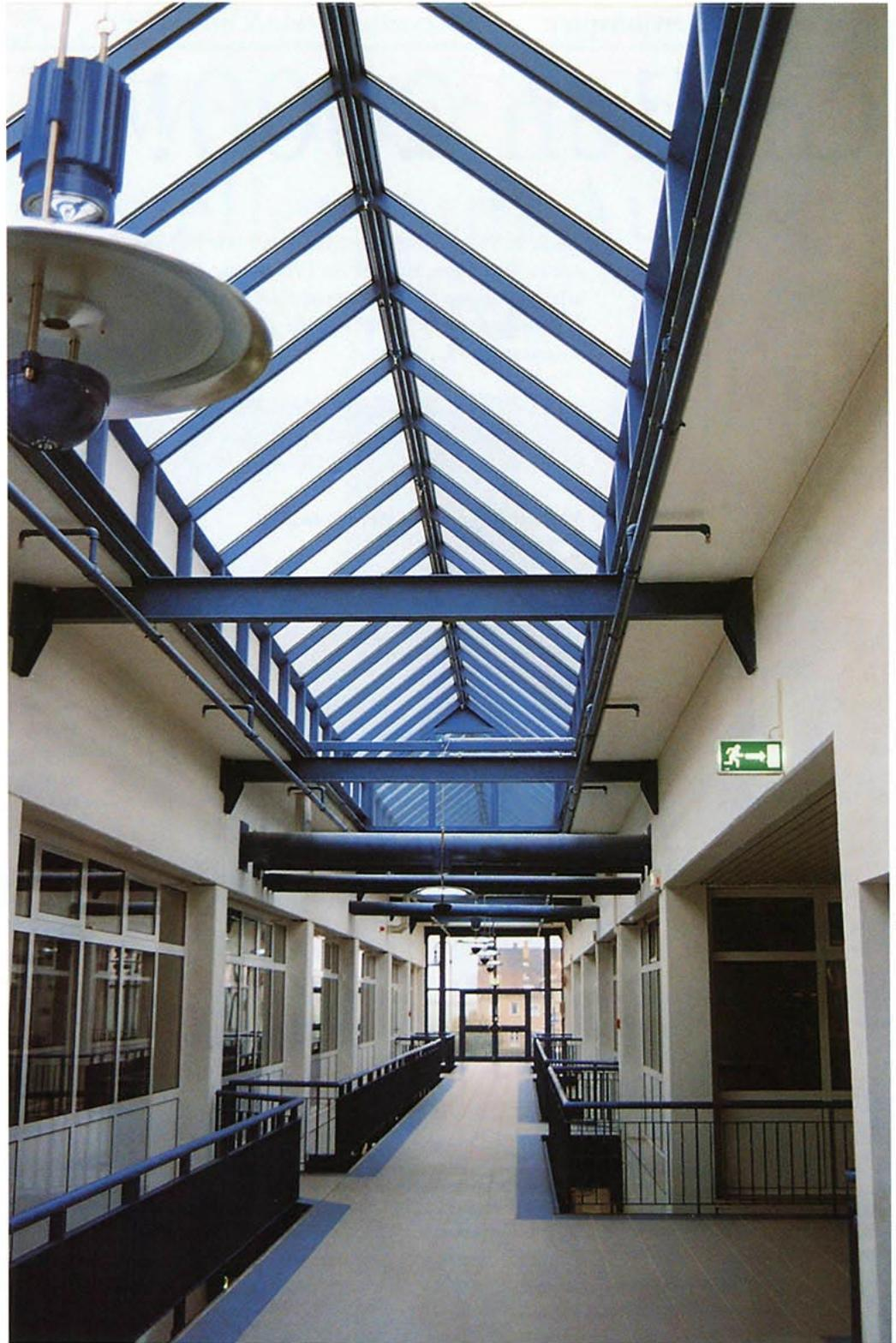
Brandschutz-Dachkonstruktion der Feuerwiderstandsklasse G 30: Witterungszugewandt ist ein wärme-/sonnenschutzbeschichtetes Isolierglas (Pilkington Pyrodur / System RP-Iso hermetic).
