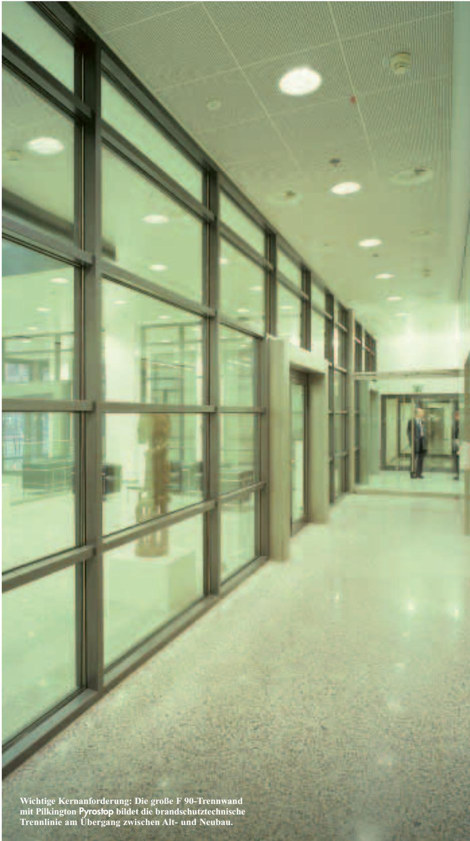
Wichtige Kernanforderung: Die große F 90-Trennwand mit Pilkington Pyrostop bildet die brandschutztechnische Trennlinie am Übergang zwischen Alt- und Neubau.
