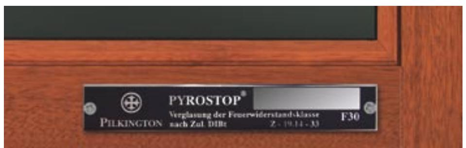
**Permanente Kennzeichnung des Brandschutzsystems:** Von dem obligatorischen Stahlblechschild können Hersteller, Systemtyp, Feuerwiderstandsklasse und Zulassungsnummer abgelesen werden. Das Stahlblechschild ist dauerhaft auf der Rahmenkonstruktion zu befestigen.
