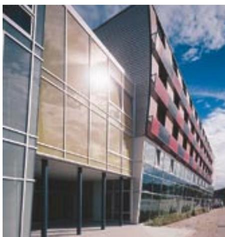
**Treppenzugang an der Wasserseite:** Die Verglasungen für die Feuerwiderstandsklasse G 30 im Erdgeschoss wurden mit Pilkington **Pyrodur** ausgeführt. Auf den filigranen Stahlstützen steht ein Erweiterungskubus des Fitnesscenters mit Gymnastikräumen.
