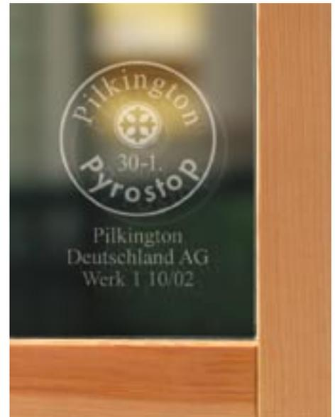
**Permanente Kennzeichnung des Brandschutzglases:** Der für alle im Brandschutz verwendeten Gläser obligatorische Ätzstempel enthält den Namen des Herstellers und die exakte Typenbezeichnung.
