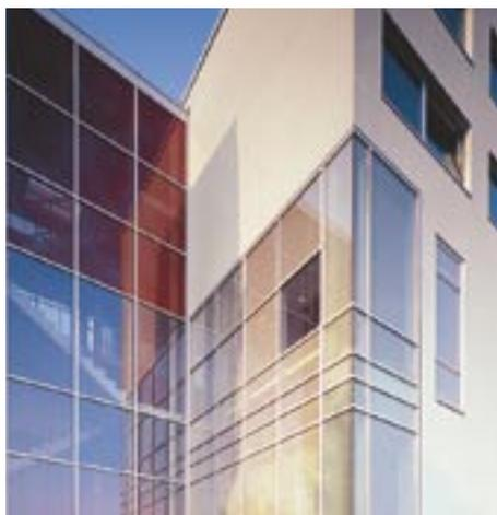
**Innenecksituation:** Zum Schutz vor Feuerüberschlag auf das Treppenhaus forderten die Behörden eine G 30-Konstruktion mit strahlungsreduzierender G-Verglasung mit Pilkington **Pyrodur** (im Bild rechts).
