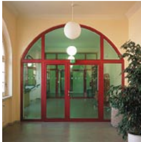
Goethe-Gymnasium, Chemnitz (F 30/T 30, fuego).
