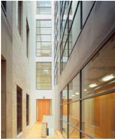
Der Lichthof zwischen dem Altbau (links) und dem Neubau Haus 7. Alle Verglasungen dieses Lichthofs sind in der Feuerwiderstandsklasse G 30 mit Pilkington Pyrodur ausgeführt.
