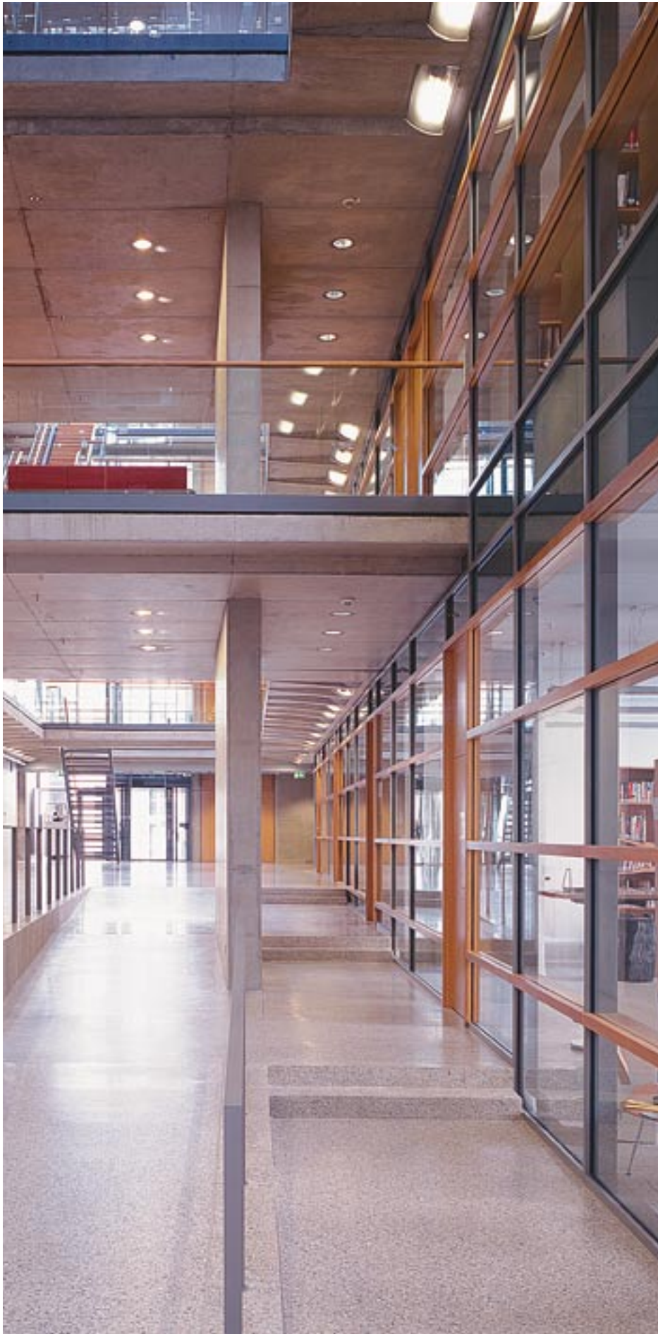
Die Stadtfuge in Haus 3, rechts die F 30-Fassade vor der Dependence der Parlamentsbibliothek (Pilkington Pyrostop/Sonderkonstruktion forster thermfix vario in Holz/Stahl-Mischbauweise).
