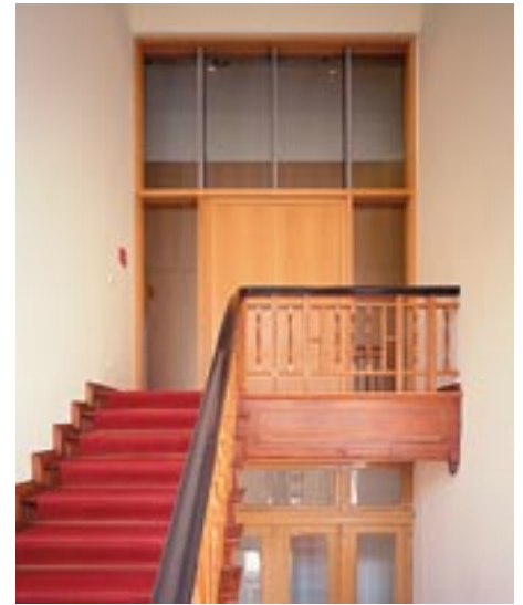
Brandschutzverglasungen mit Pilkington Pyrostop im alten Treppenraum des Hauses Sommer, eines historischen Bank- und Wohngebäudes, das in das Ensemble der Dorotheenblöcke integriert wurde.
