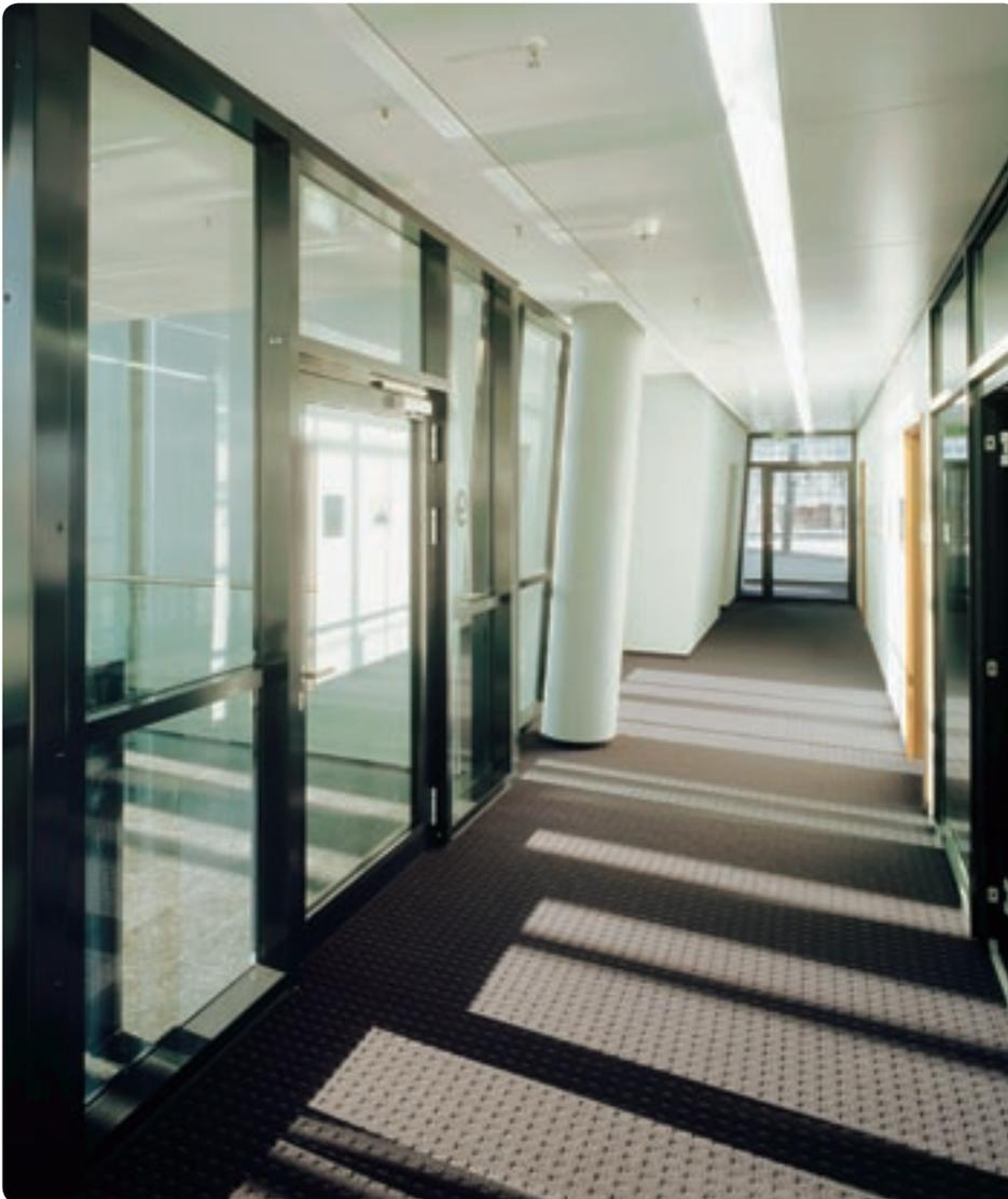
Besonderheit beim baulichen Brandschutz: Der Übergang von den geneigten G 30-Festverglasungen zu den als Einselelemente montierten F 30/T 30-1 Feuerschutzabschlüssen war Teil einer Zustimmung im Einzelfall.
