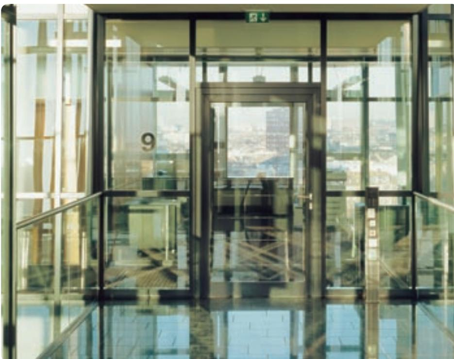
Von den Fluchtwegen aus führen verglaste Brücken zu den zentral im Gebäude positionierten Aufzugsschächten. Der Raumabschluss zum Fluchtweg ist über F 30/T 30-Türsysteme mit Pilkington **Pyrostop**<sup>®</sup> gesichert.
