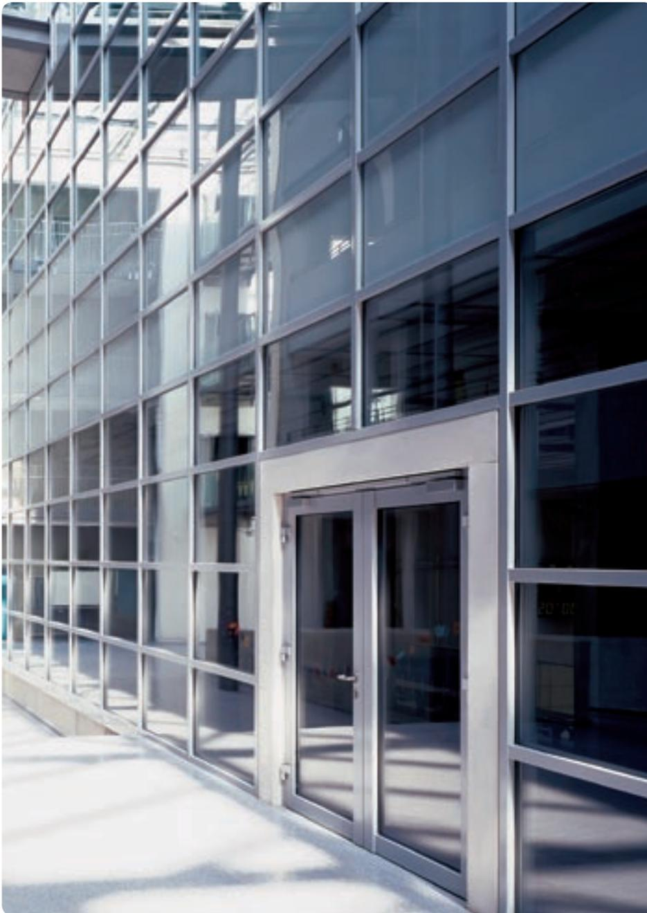
Geschossübergänge und Gebäudetechnik im Bereich von abgehängten Decken werden durch transluzente Brandschutzgläser harmonisch abgedeckt.
