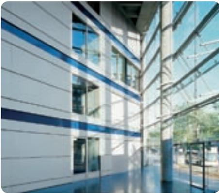
F 30/T 30-Systemkonstruktion SCHÜCO FIRESTOP II mit Pilkington Pyrostop® im Bürogebäude Deichtor in Hamburg.
