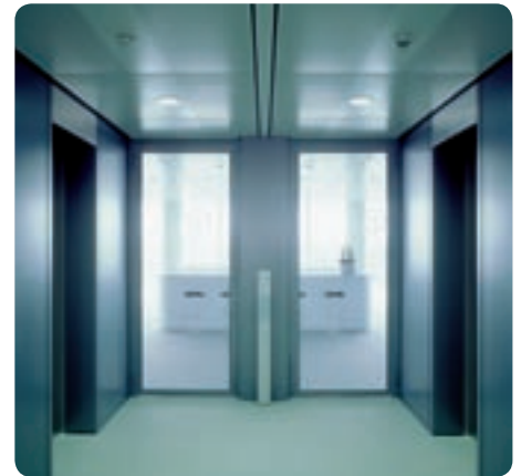
Transparente Separation: Auch die einzelnen Nutzungszonen des Hochhauses sind zu den Fluchtwegen hin durch F 30/T 30-Türsysteme abgesichert, die auf elegante Weise Brand- und Rauchschutz sicherstellen.
