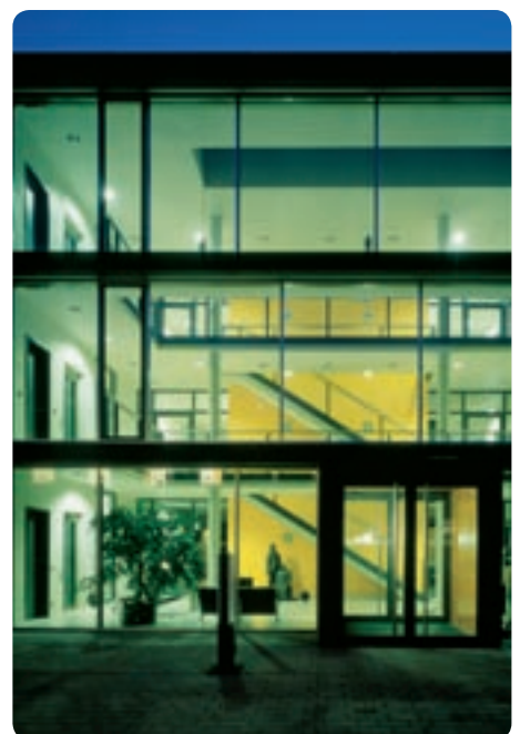
Seitenansicht eines der ComIn-Büromodule bei Nacht: Die durch F 30/T 30/RS-Türen mit Pilkington Pyrostop ® abgesicherten Rettungswege münden hier in eine zentrale Erschließungszone.
