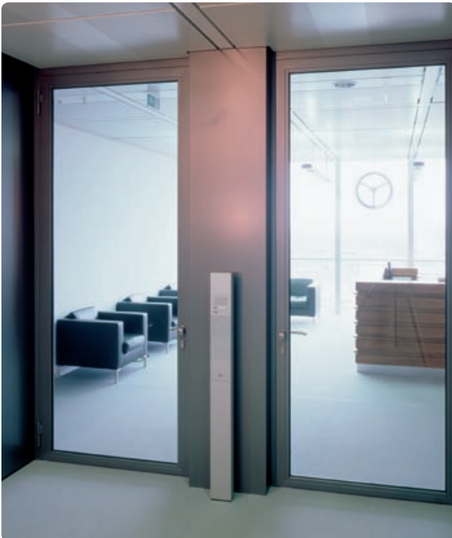
Transparente Separation: Auch die einzelnen Nutzungszonen des Hochhauses sind zu den Fluchtwegen hin durch F 30/T 30-Türsysteme abgesichert, die auf elegante Weise Brand- und Rauchschutz sicherstellen.
