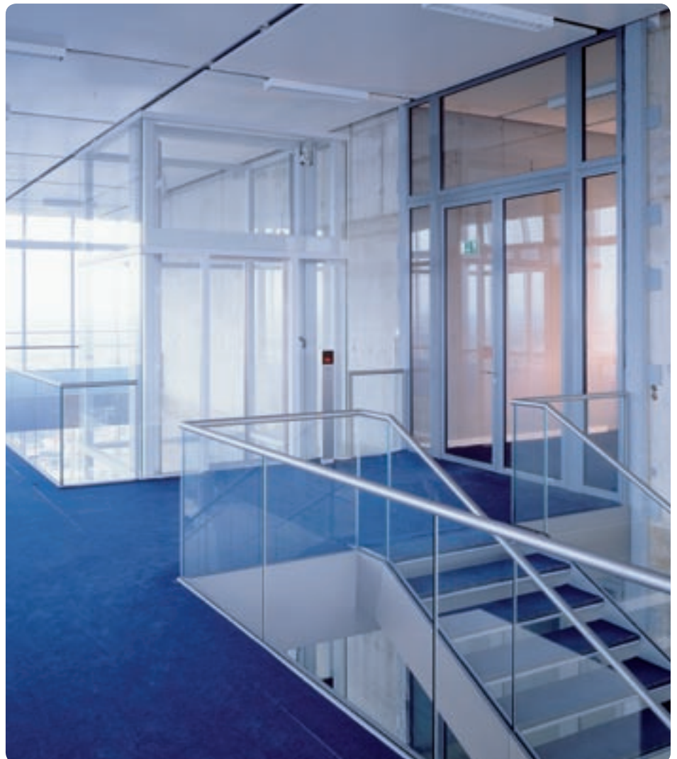
Transparenter Feuerschutzabschluss mit Pilkington Pyrostop® zur Sicherung eines Fluchtweges im Bürogebäude Uptown in München.
