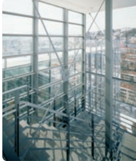
Aus der Schleuse, die mit transparenten F 30/T 30-Türsystemen (Pilkington Pyrostop ® / System forster fuego) abgesichert ist, betritt man den Treppenraum.
