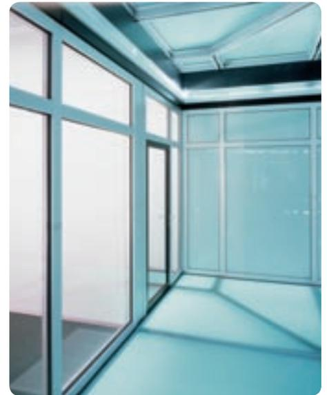
Brillante optische Qualität und Transparenz bei höchster Feuerwiderstandsklasse: Die F 90-Verglasungen mit Pilkington Pyrostop® sind aufgrund der Verwendung von eisenoxidarmem Weißglas hell und klar in An- und Durchsicht.
