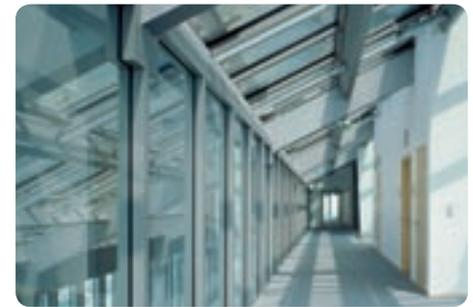
G 30-Schrägverglasung mit Pilkington **Pyrodur**<sup>®</sup> mit raumseitigen, splitterbindenden Verbund-Sicherheitsglas-Paket.
