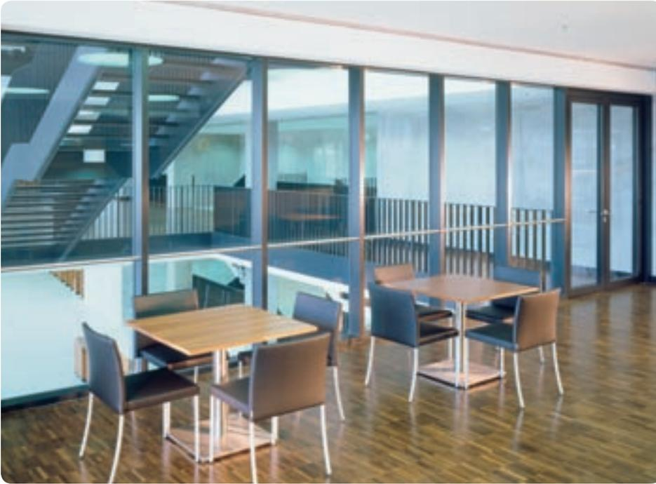
die an den Luftraum angrenzenden Fassadenteile in der Feuerwiderstandsklasse G 30, die an die Galerien angrenzenden Fassadenteile bis drei Meter in den Luftraum hinein in der Feuerwiderstandsklasse F 30 gefertigt. Diese „Mischkombination“ war ebenfalls im Rahmen der Zulassung möglich und ist dank der guten optischen Qualität der Brandschutzgläser und identischer Profilansichtsbreiten in der Ansicht völlig homogen.
