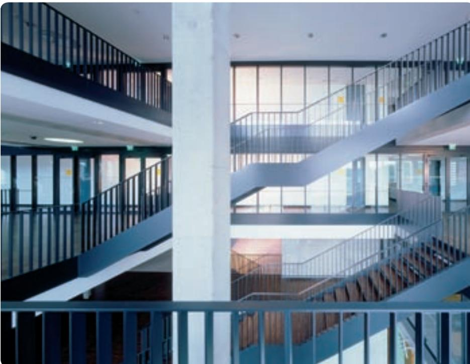
Brandschutz plus Absturzsicherung: Fassadenbereiche zum offenen Luftraum hin wurden mit Brüstungsholm an der Konstruktion versehen, um die Zusatzanforderung angesichts der 3 m hohen Brandschutzglaselemente zu erfüllen.
