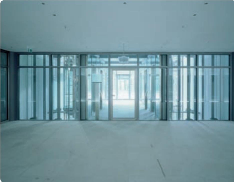
Feuerbeständige Türsysteme und Anschlussbauteile zur Absicherung des Aufzugsschachtes gegenüber den angrenzenden Nutzflächen (Pilkington **Pyrostop**<sup>®</sup> / System MBB).
