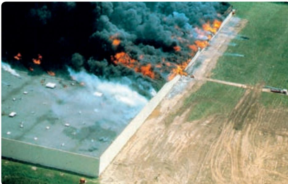
Der Worst Case: Mangelhafte Brandabschnittsbildung und fehlende oder unzureichende Sprinklerung führen in Verbindung mit brennbaren Isolationsmaterialien schnell zu einem Brandszenario mit Totalverlust.
