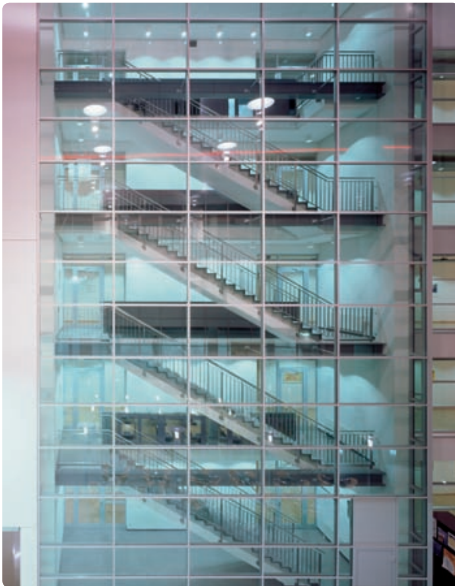
Der Mensch flieht immer dem Licht entgegen: Fluchttreppenraum mit F 30-Fassadenverglasungen und T 30-Türen im Atrium des Oberlandesgerichts in Hamm.
