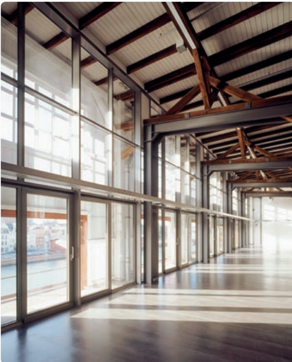
Die großflächig verglasten, filigran profilierten Brandschutzsysteme harmonieren mit der historischen Holzkonstruktion des ehemaligen Lagergebäudes.
