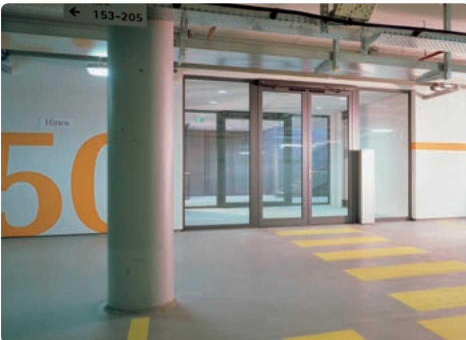
Brandschutz plus Sicherheit in Verkehrsbereichen: Trennwand-/Türanlagen mit über 3 Meter hohen Flügeln und ungeteilten Verglasungen (ohne Querriegel) sind ein bevorzugter Einsatzbereich für die neuen, leichteren Brandschutzgläser.
