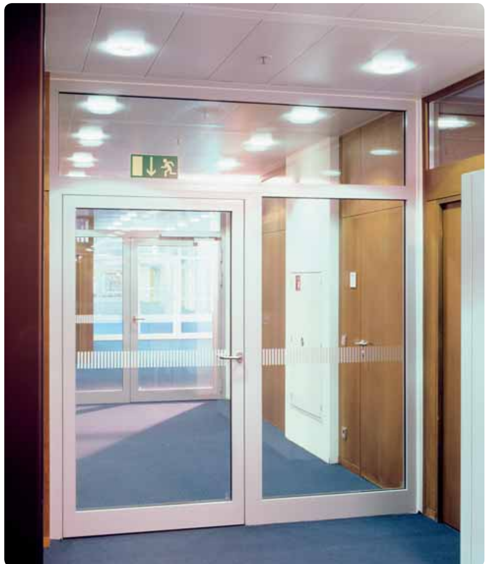
Einflügeliger T 30-Feuerschutzabschluss mit Pilkington Pyrostop ®.
