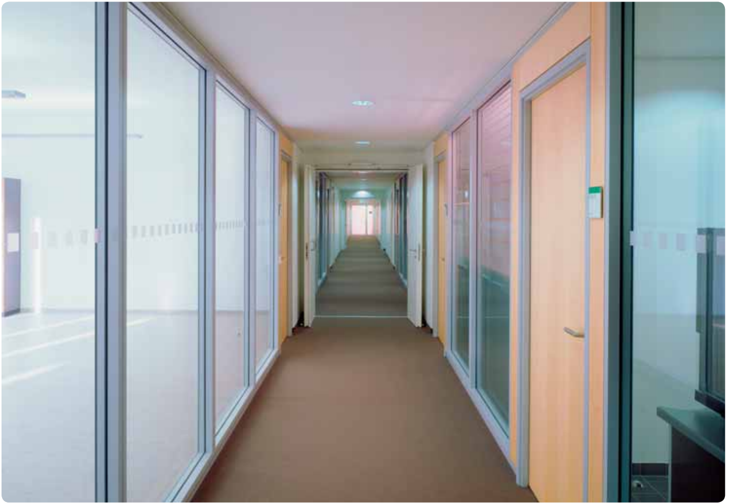
Trennwand-/Türsystem für die Feuerwiderstandsklasse F 30 im Bürogebäude Nordbahnhof in Berlin.
