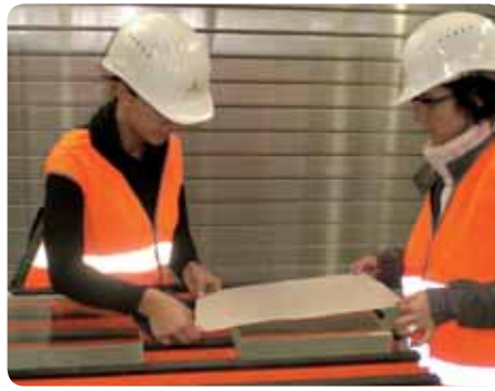
Präzisionsarbeit: Vorsichtiges Aufsetzen und anschließendes blasen- und verletzungs-freies Aufziehen sorgen für eine makellose Optik.
