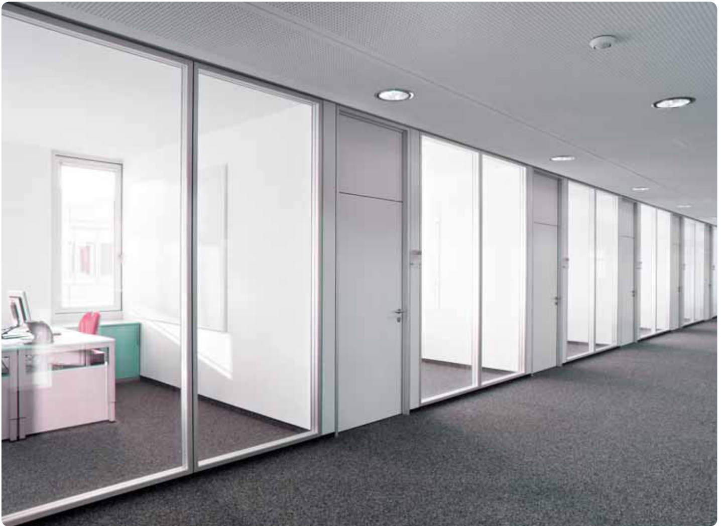
Ganz in weiß: Großflächige Pilkington Pyrostop ®-Elemente in einer Systemwand für die Feuerwiderstandsklasse F 30 im Bürogebäude der ESG GmbH in Fürstenfeldbruck.
