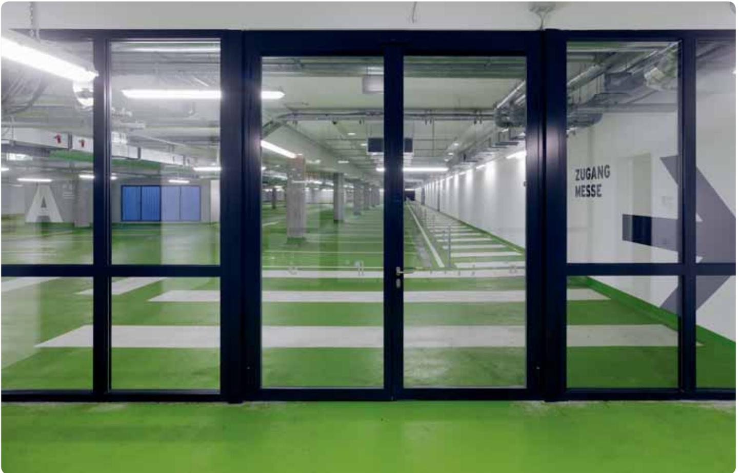
Vollständig transparent ausgeführt sind die Schleusen, die vom Parkhaus unterhalb des Eingangs Ost in die Treppenträume führen. Hier wurden T 30-Türsysteme über F 90-Stahlpfostenkonstruktionen mit der angrenzenden F 90-Festverglasung verbunden (Pilkington **Pyrostop**®/Systeme Jansen-Janisol 2 EI 30 und Schüco Firestop F90).
