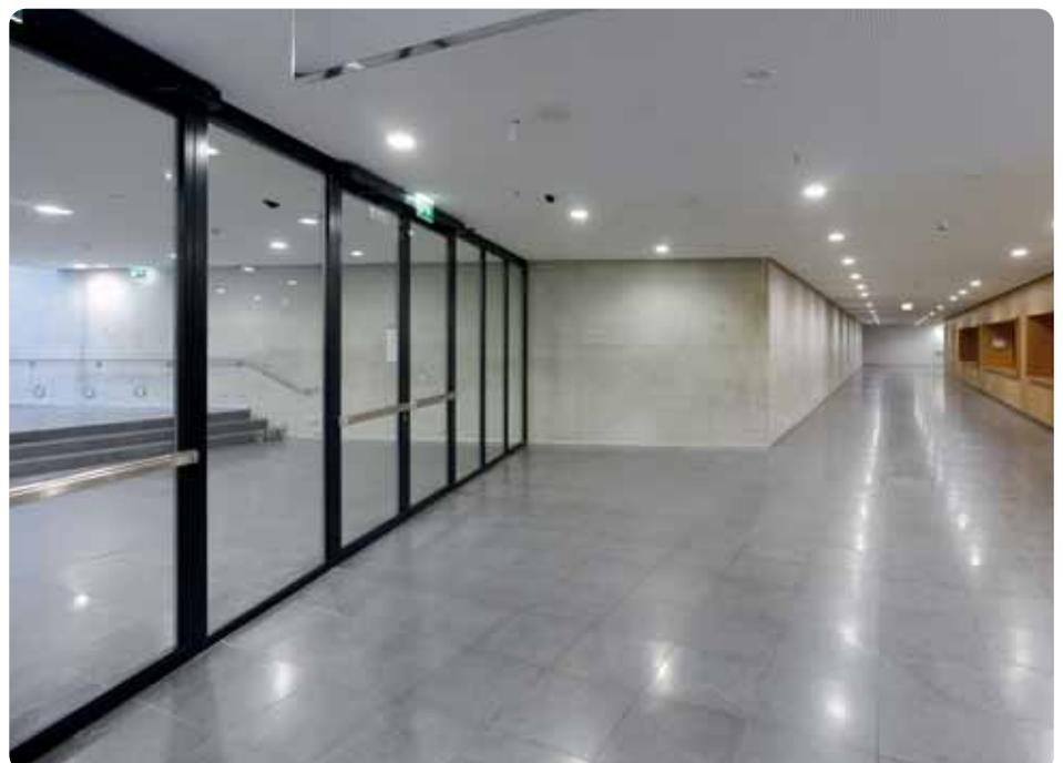
Tür-Trennwandsystem zwischen Garderobe und dem Aufgang zum Foyer des Eingangs Ost: Die F 30/T 30-Konstruktionen haben Elementhöhen von 2,80 m; Türsysteme sind mit Panik-Pushstangen ausgestattet.
