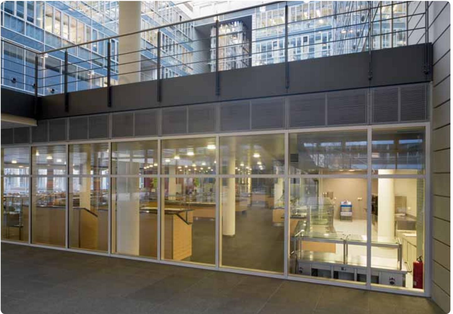
Brandschutzverglasungen verhindern im Brandfall eine geschossübergreifende Brandübertragung (Pilkington Pyrostop®/System Forster).
