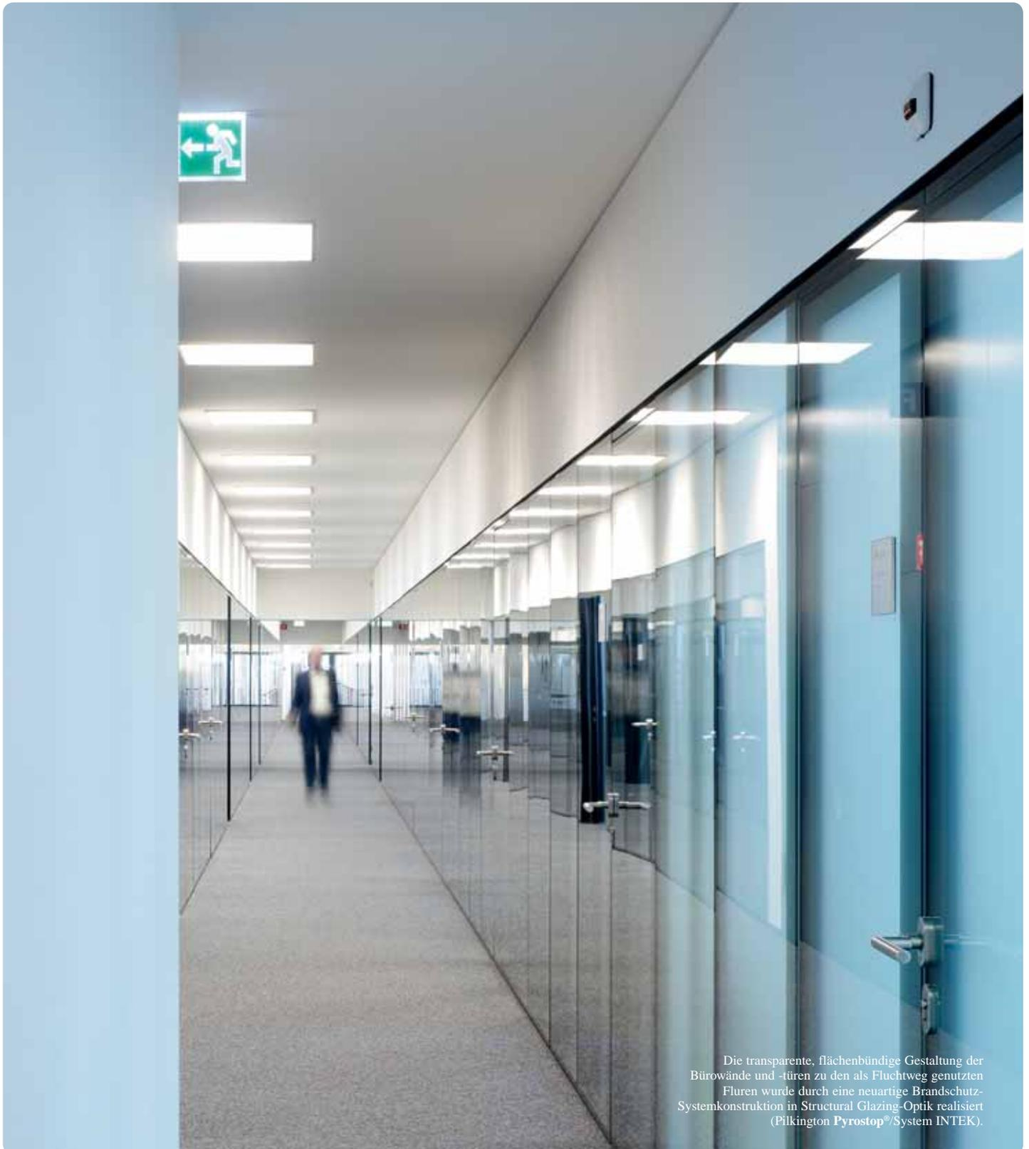
Die transparente, flächenbündige Gestaltung der Bürowände und -türen zu den als Fluchtweg genutzten Fluren wurde durch eine neuartige Brandschutz-Systemkonstruktion in Structural Glazing-Optik realisiert (Pilkington Pyrostop® System INTEK).
