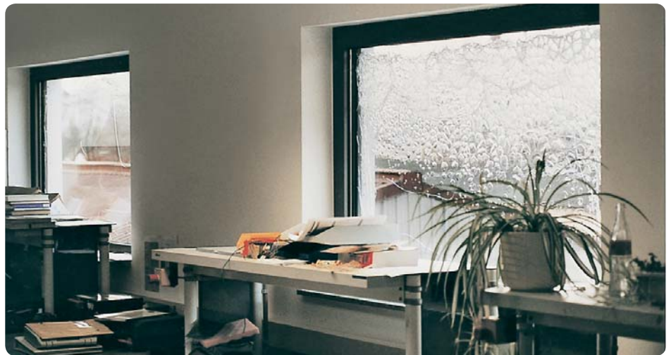
Der Brand im angrenzenden Gebäude entwickelte eine derartige Hitzestrahlung, dass die Pilkington Pyrostop®-Brandschutzgläser aufschäumend reagierten und damit den angrenzenden Bürobereich thermisch schützten.
