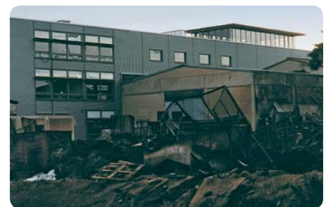
Der Brand im angrenzenden Gebäude entwickelte eine derartige Hitzestrahlung, dass die Pilkington Pyrostop®-Brandschutzgläser aufschäumend reagierten und damit den angrenzenden Bürobereich thermisch schützten.
