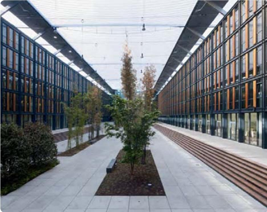
Erschließungszone und flexibler Raum für Sonderveranstaltungen: In Nord-Süd-Richtung verläuft die 200 m lange Erschließungshalle, die mit einer transluzenten Folienkissen-Konstruktion überdacht ist.
