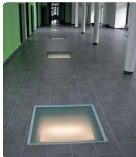
Begehbare Brandschutzverglasung für F (EI) 90 in den Böden einer Schule in Garching (Pilkington **Pyrostop**®/System Metallbau Klass).
