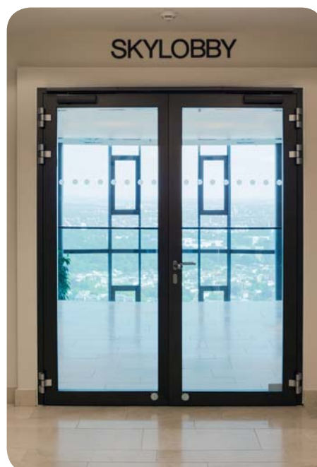
Transparente Feuerschutzabschlüsse als Zugang zur Skylobby im 49. Obergeschoss.
