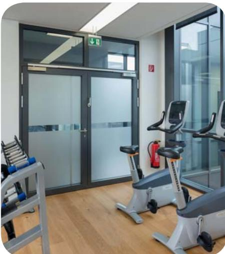
T 30-2 Türsystem als Fluchtwegzugang aus dem Fitness-Bereich. Die Pilkington Pyrostop®-Verglasungen der Türflügel wurden hier mit Sichtschutzfolien ausgestattet.
