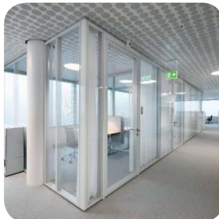
Glaswände und Türen zu den Kommunikationszonen erfüllen die Brandschutzanforderungen EI(F) 30 (Strähle Glaswand-system 2300 / Pilkington **Pyrostop**®). Die hier sichtbaren EI(T) 30 Türen mit weiß emaillierten Außenscheiben sind eine Sonderkonstruktion, die am ift Rosenheim im Rahmen von 11 Norm-Brandprüfungen und Dauerfunktionsprüfungen getestet wurde. Foto: Strähle / Marc Eggmann, Basel.
