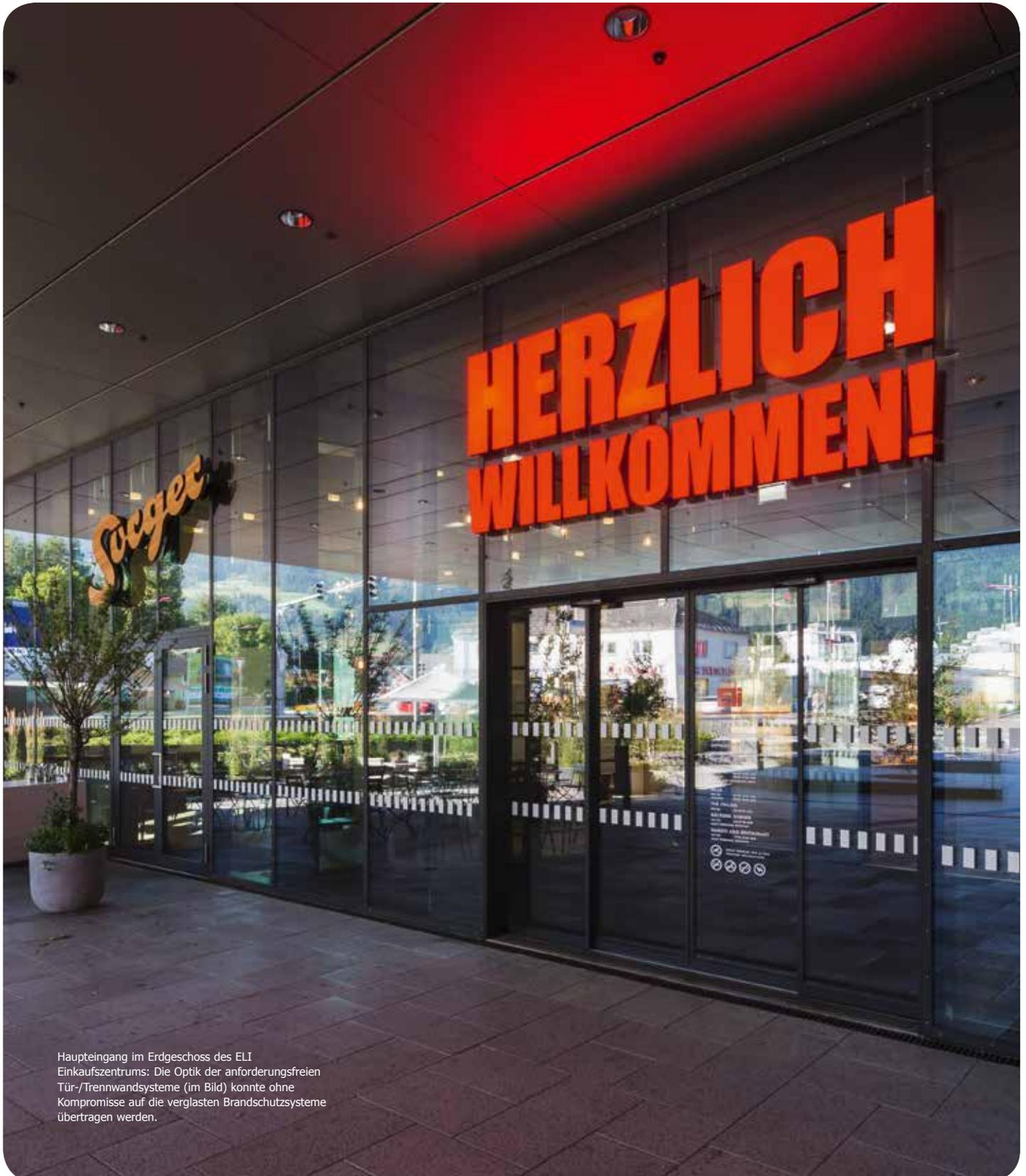
Haupteingang im Erdgeschoss des ELI Einkaufszentrums: Die Optik der anforderungsfreien Tür-/Trennwandsysteme (im Bild) konnte ohne Kompromisse auf die verglasten Brandschutzsysteme übertragen werden.
