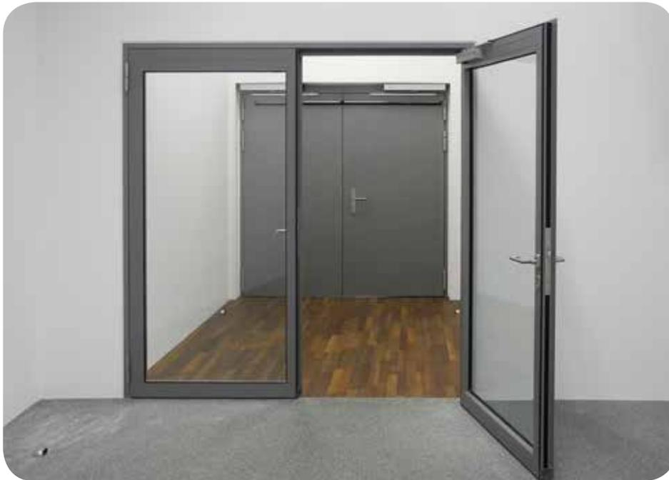
Türschleuse im Erschließungsbereich der historischen Markthalle: EI(T) 30 Feuerschutzabschlüsse – mal transparent (Pilkington **Pyrostop**®/System Forster Fuego), mal vollflächig mit Stahlblech beplankt).
