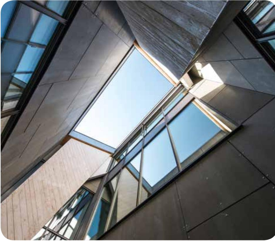
Die nach oben offenen Atrien des Bauteils C sind im EG mit dem System Jansen VISS Fire TVS/ Pilkington **Pyrostop**® in EI 90 ausgeführt und oberhalb im gleichen System in EI 30 weitergeführt. Bildnachweis: Jansen AG, Oberriet
