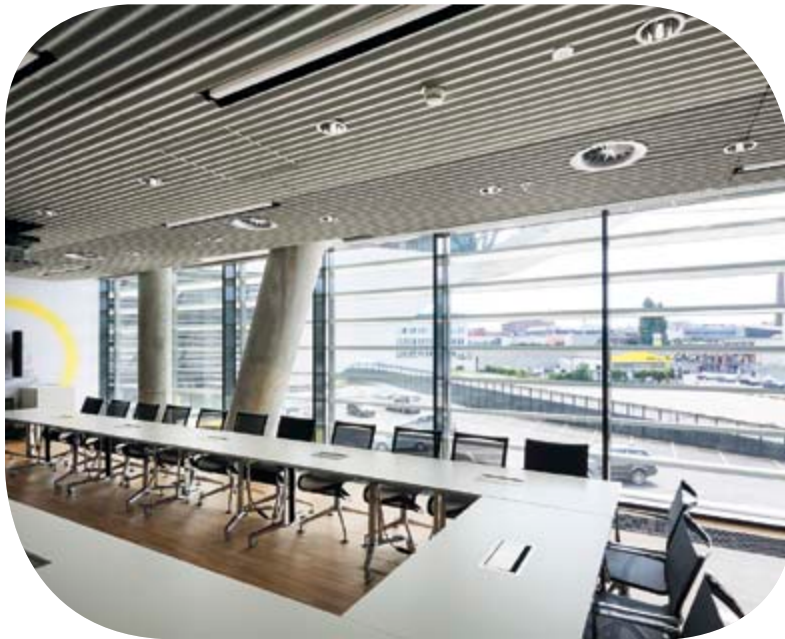
Großflächige Brandschutzverglasungen mit Pilkington Pyrostop ® der Feuerwiderstandsklasse EI 30 in ungeteilten, raumhohen Fassadenelementen.
