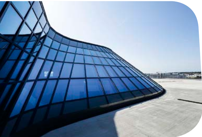
Eine geschwungene Schrägverglasung krönt das Dach. In der seitlich leicht schräg geneigten Verglasung kam Pilkington Pyrostop ® 60-181 zum Einsatz.
