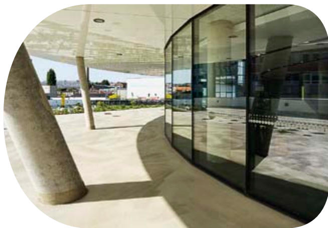
Fassadensystem mit Pilkington Pyrostop ® schützt vor Feuerüberschlag auf die oberhalb liegenden Flucht- und Rettungswege und Bürogeschosse.
