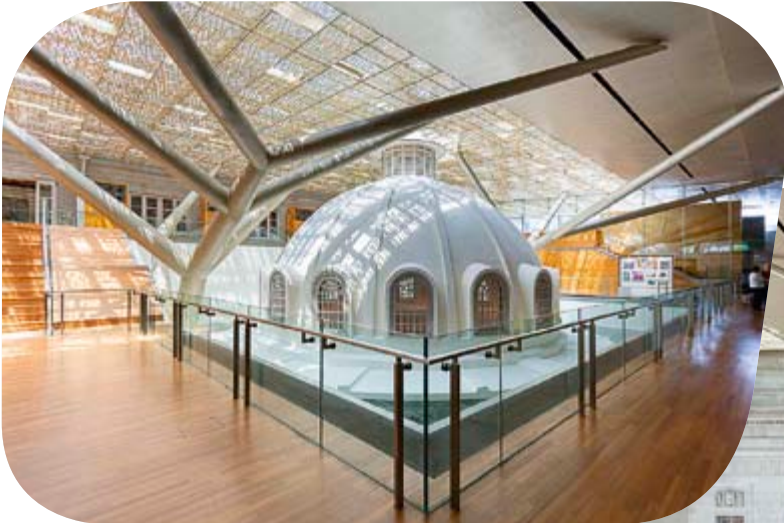
Die neue Dachkonstruktion umschließt die historischen Gebäude, ohne konstruktiv in die denkmalgeschützte Architektur einzugreifen.
