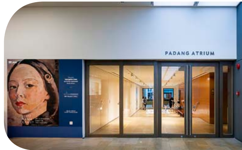
Die Standardabmessungen der zweiflügeligen Türsysteme betragen 2.300 mm × 2.400 mm.
