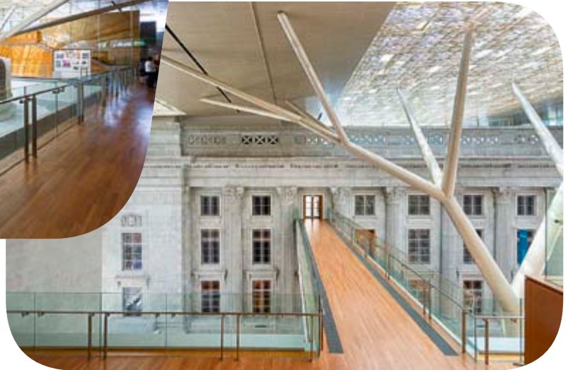
Die neue Dachkonstruktion umschließt die historischen Gebäude, ohne konstruktiv in die denkmalgeschützte Architektur einzugreifen.
