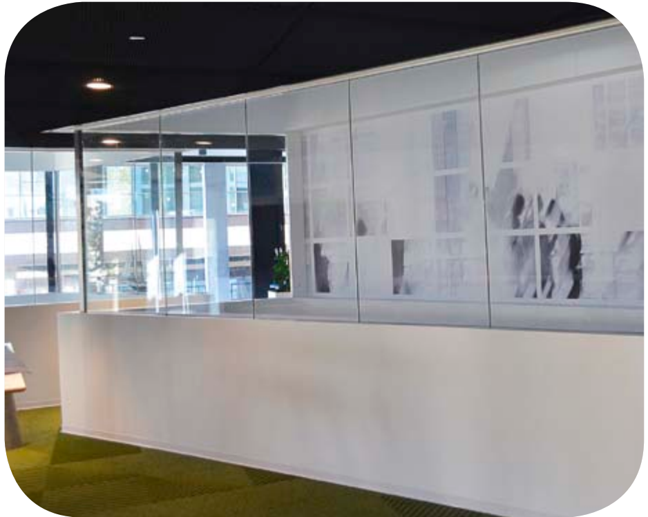
Verglasung mit Pilkington Pyrostop ® Line 30-604 OW (22 mm) – C&P Immobilien AG in Österreich.
