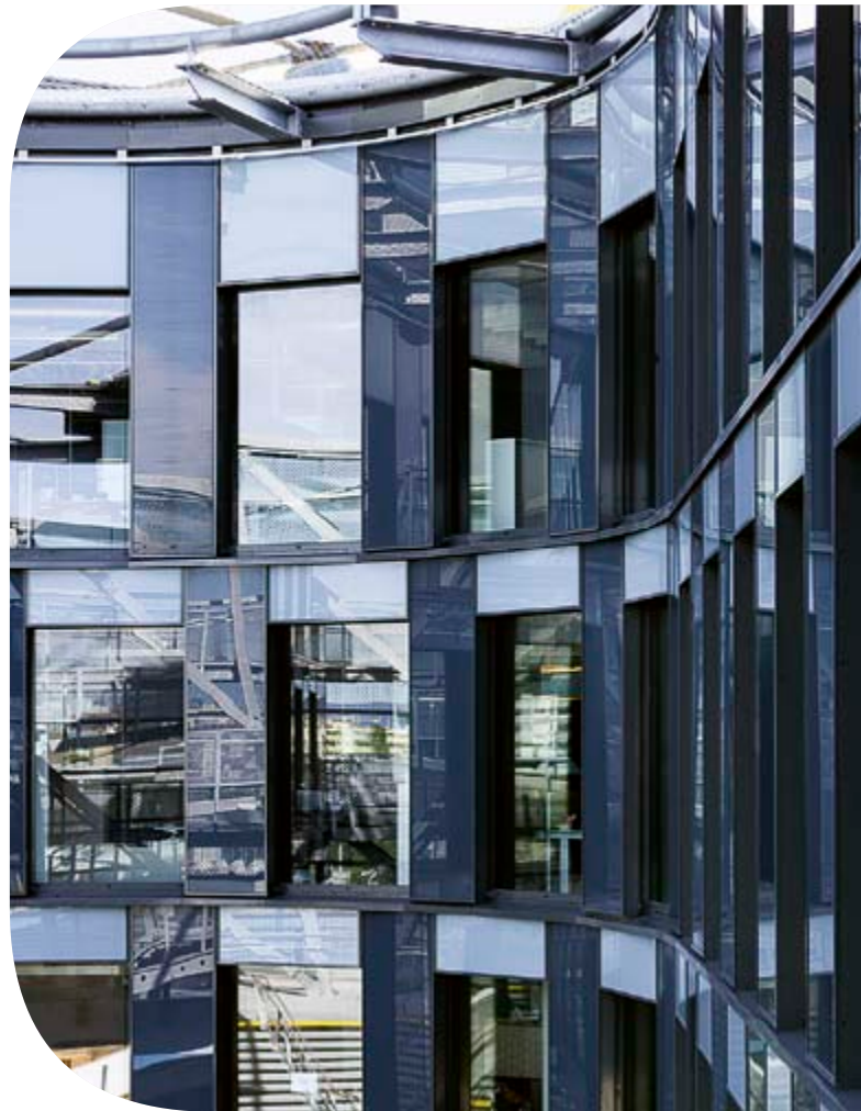
Die Innenfassade im Kern des ÖAMTC-Gebäudes ist zum Schutz vor vertikalem Feuerüberschlag vollständig als Brandschutzfassade mit Pilkington Pyrostop® Isolierverglasungen ausgeführt.
