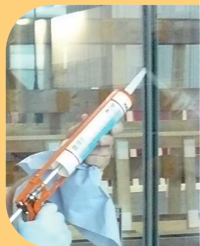
Abdichten der ca. 5 mm breiten Stoßfuge mit geeignetem Dichtstoff auf Silikonbasis.
