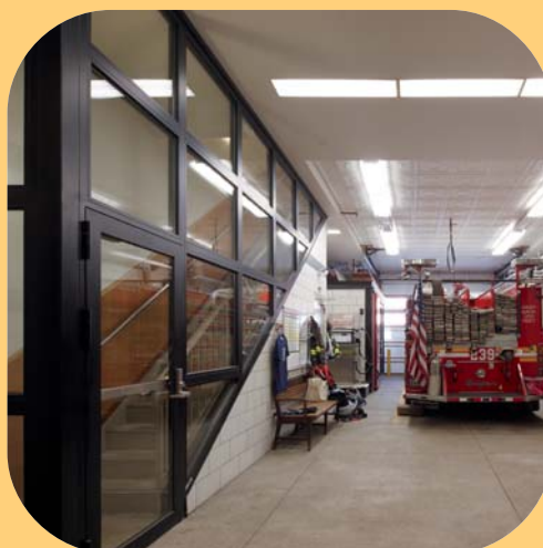
Pilkington Pyrostop ® F (EI) 120- Abtrennung zum Treppenhaus in der Feuerwache, New York.
