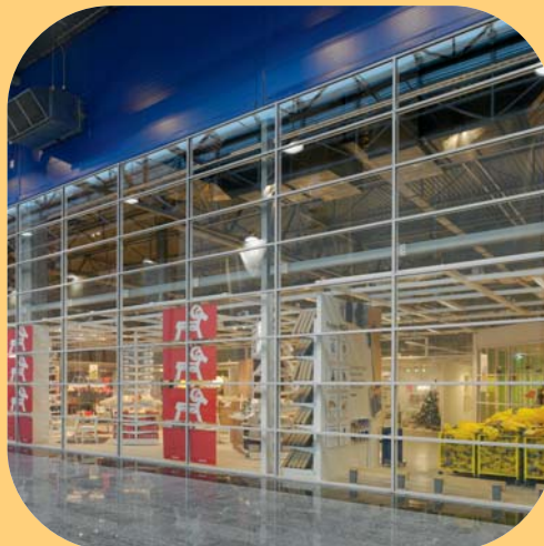
Trennwand mit Pilkington Pyrostop ® F (EI) 30. Ikea, Moskau.
