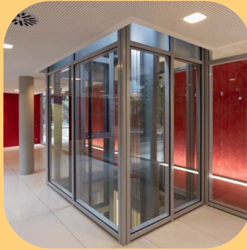
F (EI) 30/T 30-Innenfassade mit Brandschutzeinhausung eines Aufzugsschachtes im Verwaltungsgebäude der LVM, Münster.
