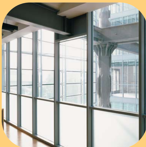
(Bild links) Pilkington Pyrodur ® -Isoliergläser, unterhalb des Querriegels mit integrierter Sichtschutzfolie, in der G (EW) 30-Innenfassade der sanierten Alten Mälzerei, Düsseldorf.
