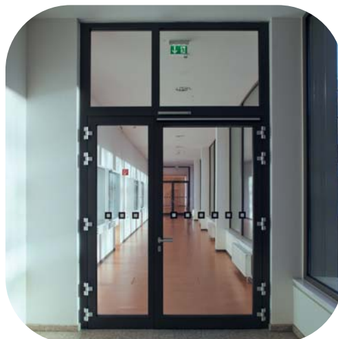
(Bild links) T 90-Türsystem mit Pilkington Pyrostop® als Öffnung in einer Brandwand im Land- und Amtsgericht, Düsseldorf.
