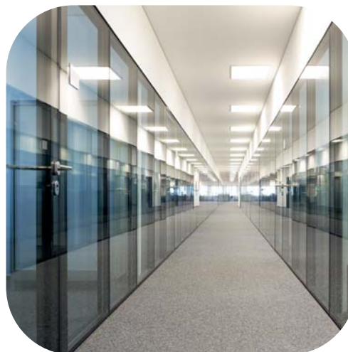
F (EI)/T 30 Tür-/Trennwandsystem mit mittig integrierten Pilkington Pyrostop ®-Glaselementen im WHO Verwaltungsgebäude, Genf.
