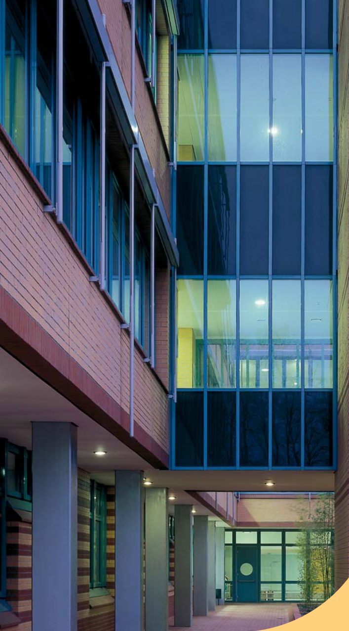
Pilkington Pyrodur ® -Isoliergläser für Verglasungen der Feuerwiderstandsklasse G (EW) 30 in der Fassade des Klinikums Marzahn, Berlin.
