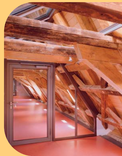
Verglastes T 30-Brandschutzsystem mit filigranen Rahmenkonstruktionen im denkmalgeschütztem Alten Schloss, Bietigheim.
