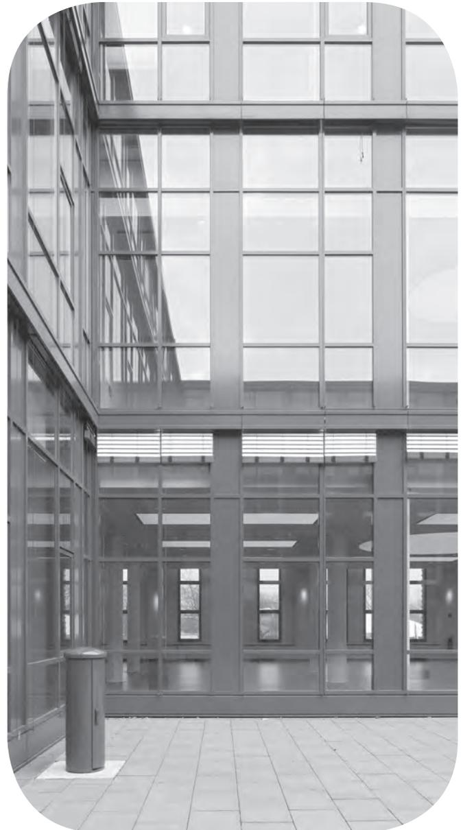
Pilkington **Pyrostop®** mit Low-E-beschichteter Scheibe (z. B. mit Pilkington **Optitherm™ S3**-beschichteter Scheibe) für die EI(F) 30-Klasse
