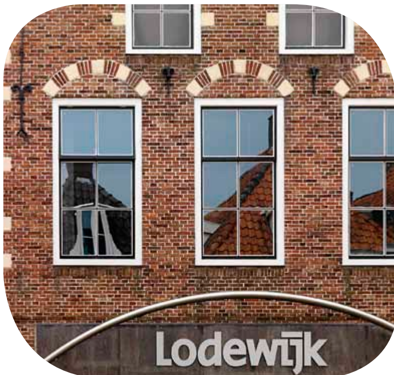
Historisches Gebäude in Franeker, Niederlande. Bauherr: D&O Bouwglas. Pilkington Spacia™
