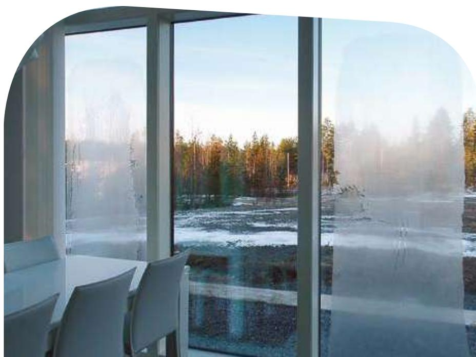
Mittig im Bild sehen Sie Pilkington Anti-condensation Glass integriert im Wärmedämm-Isolierglas. Die beiden äußeren Isoliergläser ohne Antikondensationsbeschichtung zeigen auf der Außenscheibe Kondensatbildung.
