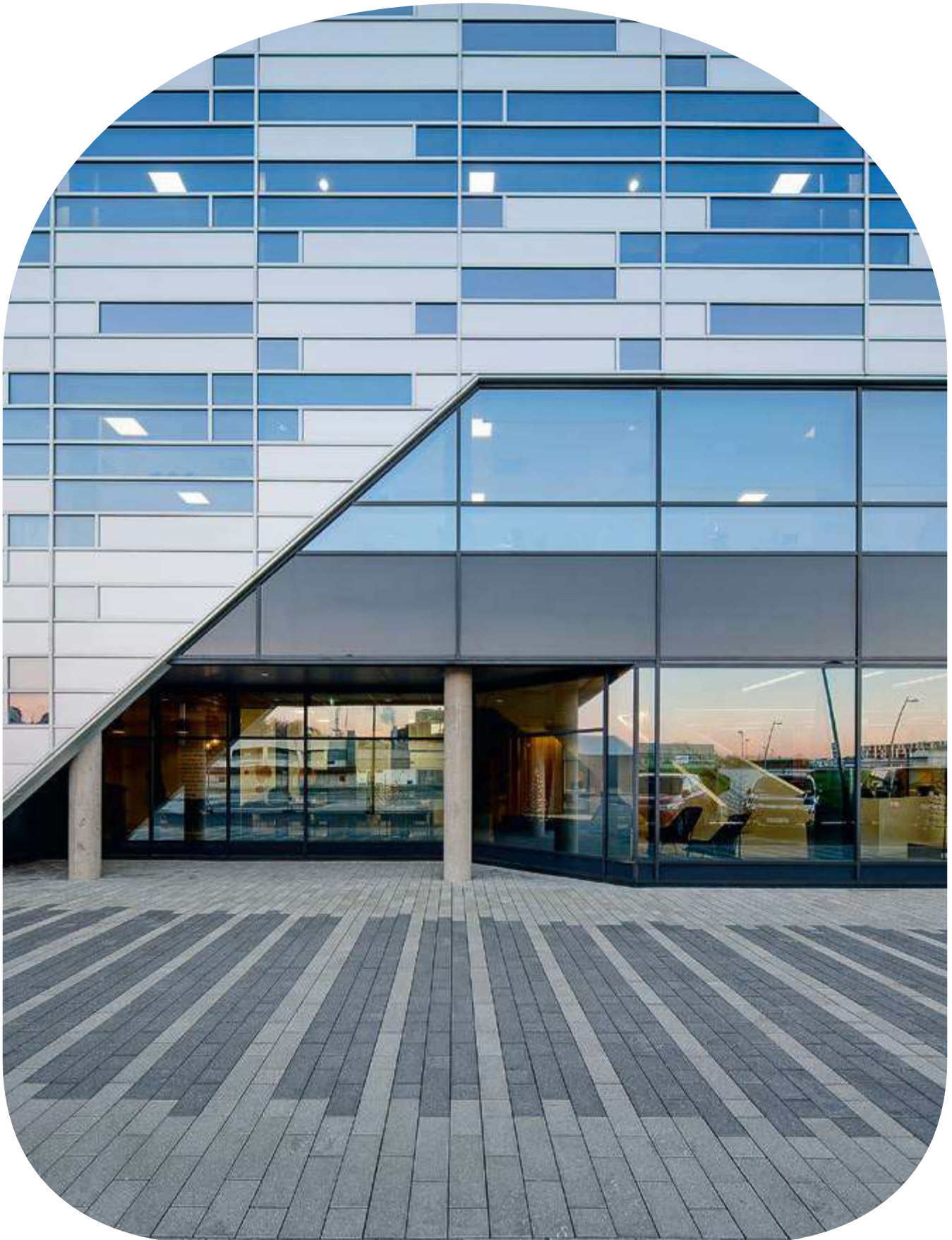
Havnespeilet, Sandnes, Norwegen. Pilkington Fassadenplatten Pilkington Suncool™ 30/17
