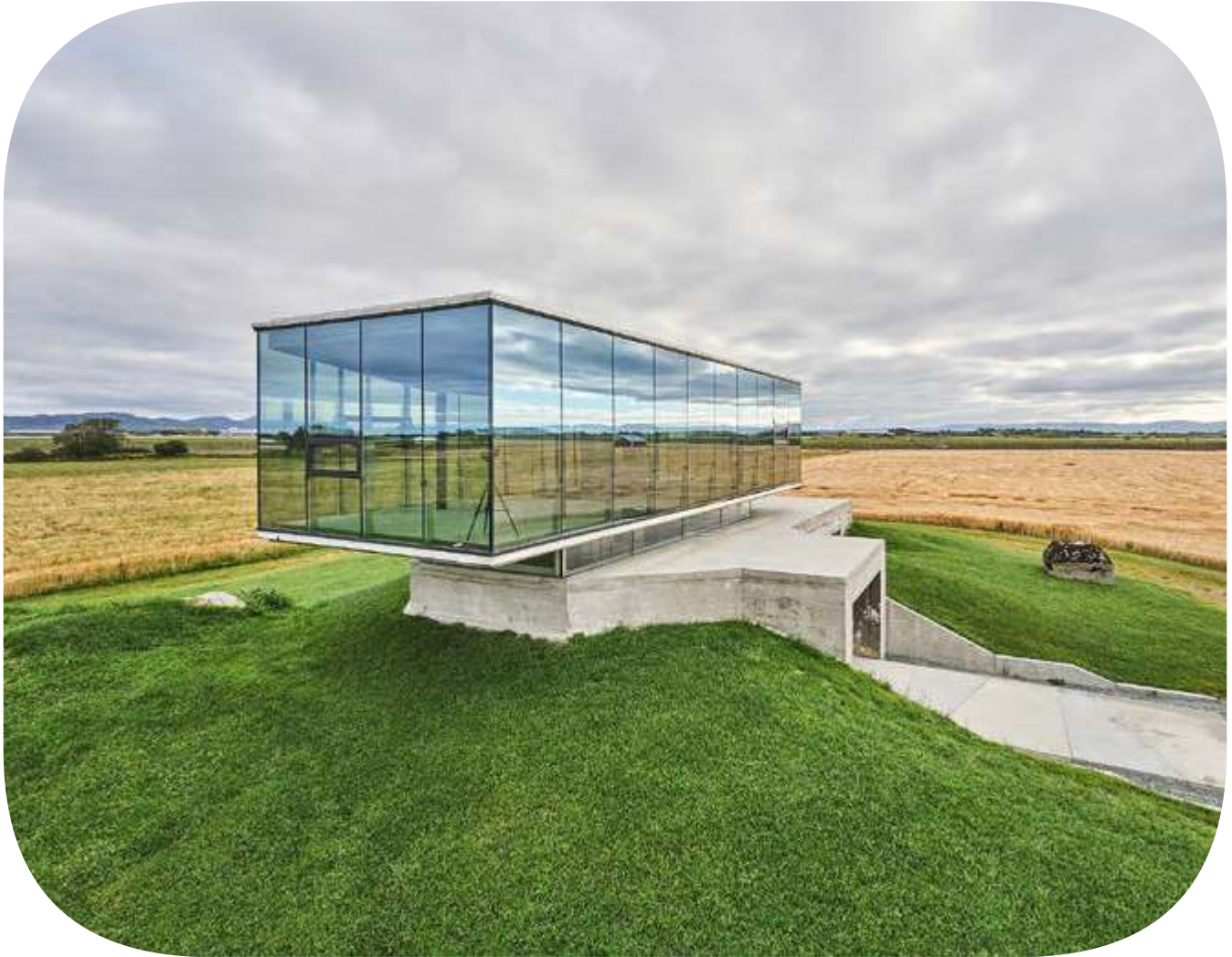
Pavillon Brekstad, Norwegen. Pilkington Insulight Activ™ . Äußeres Glas: Pilkington Activ Suncool Optilam™ T 50/25 Inneres Glas: Pilkington Optilam™ Clear T
