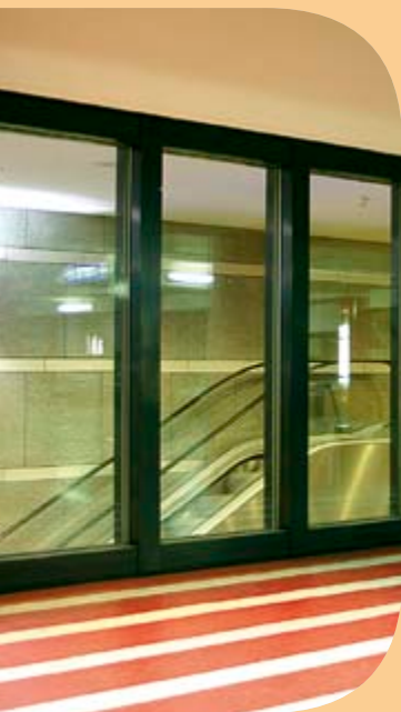
Ścianka działowa o klasie EI 180 ze szkła Pilkington Pyrostop ® – Centrum Handlowe, Boulogne (Francja)
