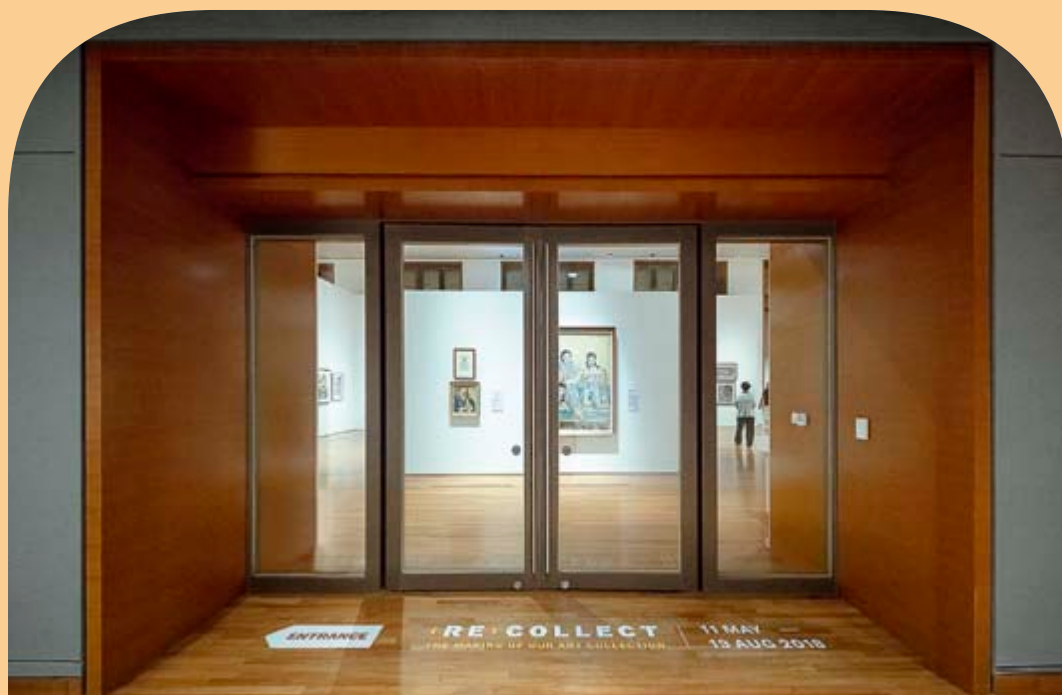
Dwuskrzydłowe drzwi z bocznymi naświetlami ze szkła Pilkington Pyrostop ® – National Art Gallery, Singapur
