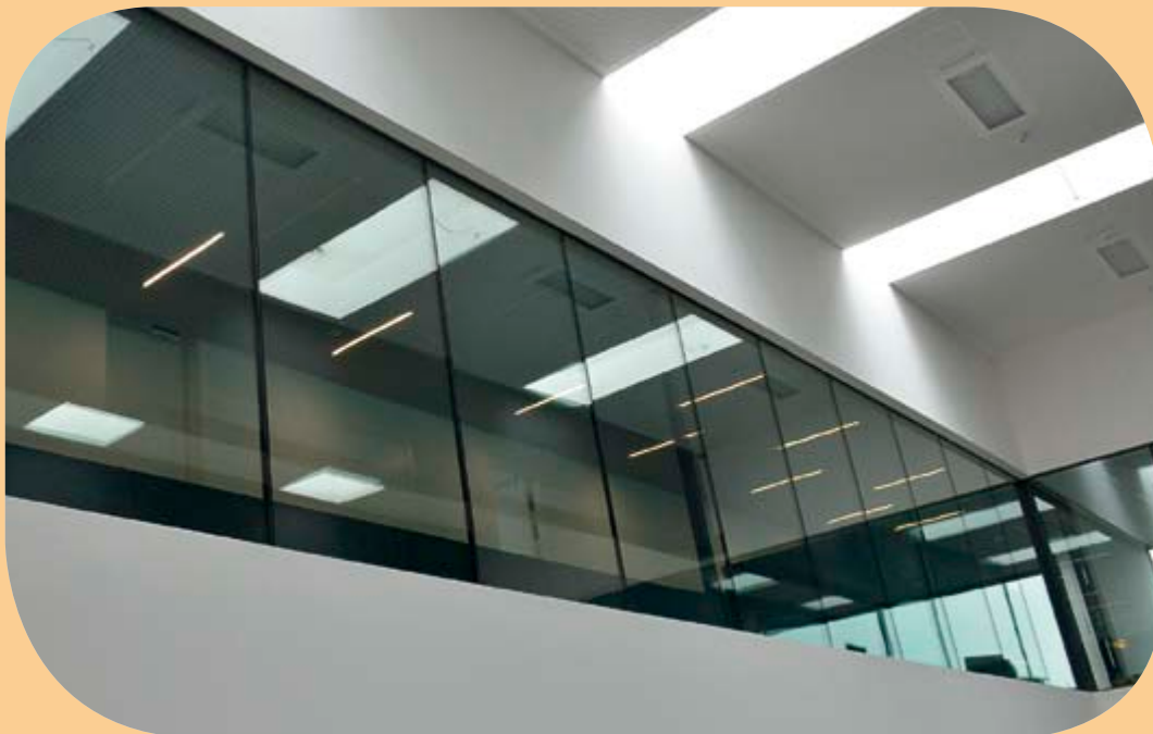
Przegroda ze szkła Pilkington Pyrostop ® Line Triple – Siedziba główna STEINBAUER, Wartberg/Aist (Austria) © STEINBAUER Performance
