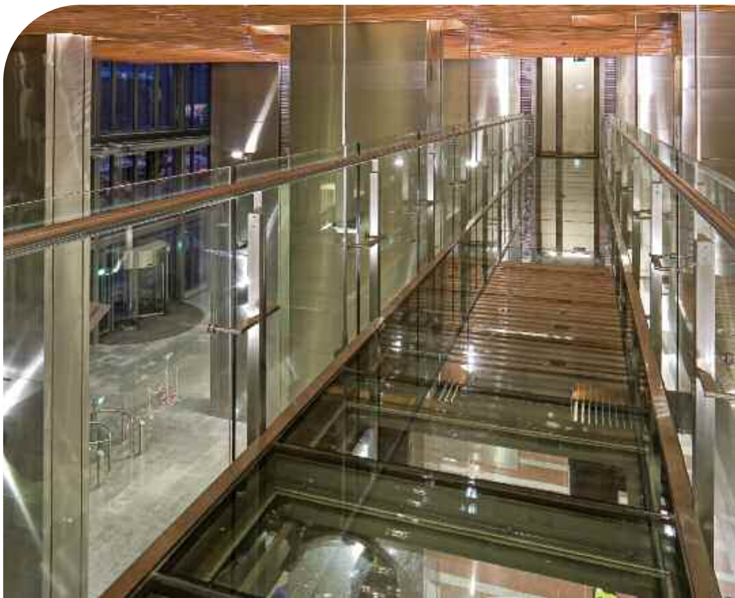
Для остекления пешеходного мостика в офисном здании «Rondo 1» в Варшаве было использовано стекло Pilkington Pyrostop ™ 60-50.
